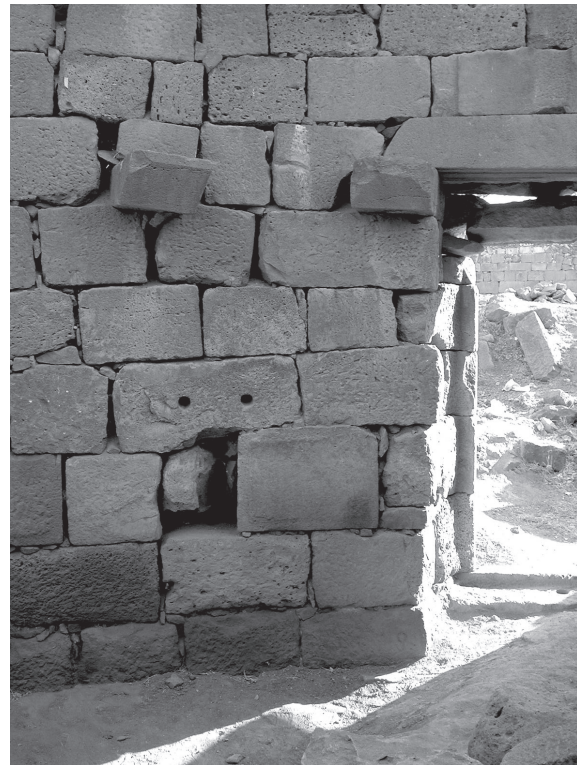
Figure 12. Dans la salle semi-circulaire, des corbeaux à sifflet ont été incrustés en sous-œuvre dans le mur. Vue depuis le nord-ouest. © P.-M. Blanc 2000.
