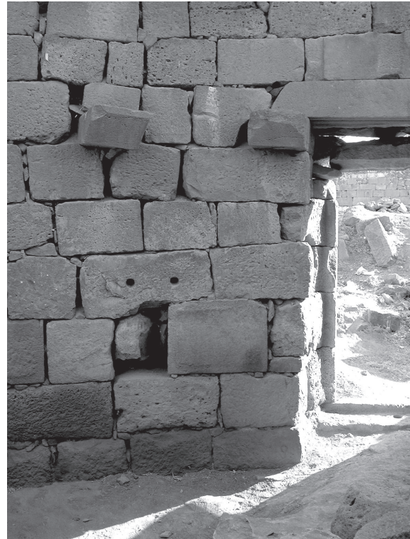
Figure 12. Dans la salle semi-circulaire, des corbeaux à sifflet ont été incrustés en sous-œuvre dans le mur. Vue depuis le nord-ouest.
