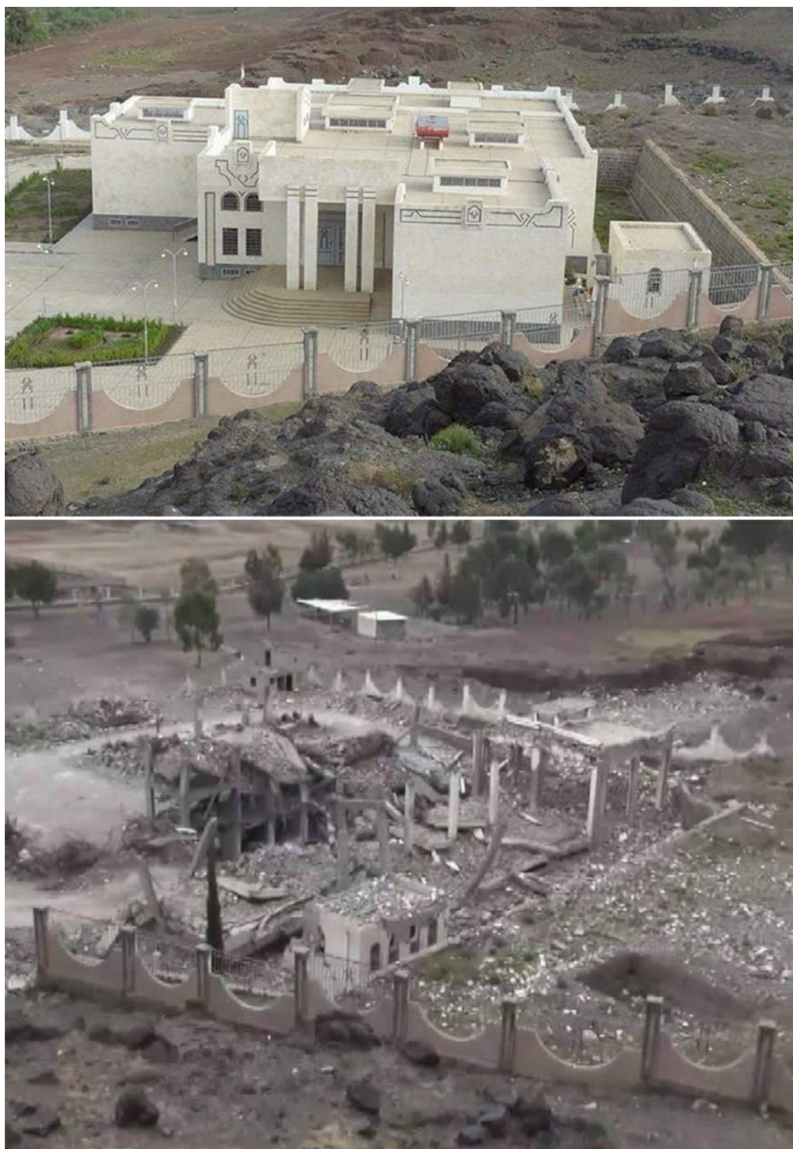
FIG. 19: Dhamār, musée archéologique après achèvement (haut) et après bombardement aérien (bas) (haut : GOAM, bas : Hussain Albukhaiti).
