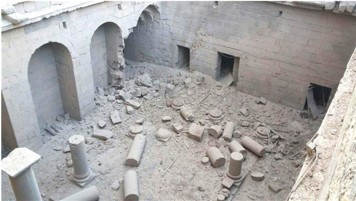
FIG. 6: Bosra, théâtre : conséquences des bombardements, frappe aérienne de l'armée du régime (© D.A. Bosra Al Sham)
