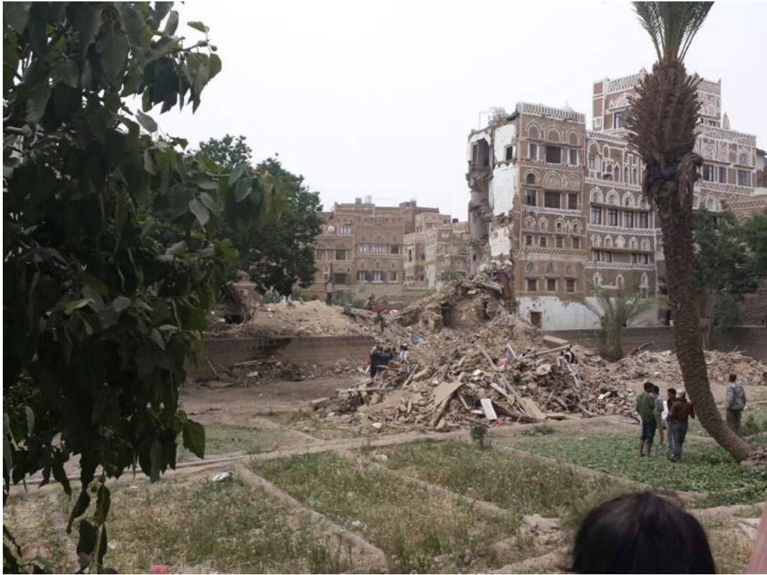
FIG. 16: Sanaa, maisons-tours de la vieille ville détruite par des bombardements aériens (Muhannad al-Siyani/GOAM).
