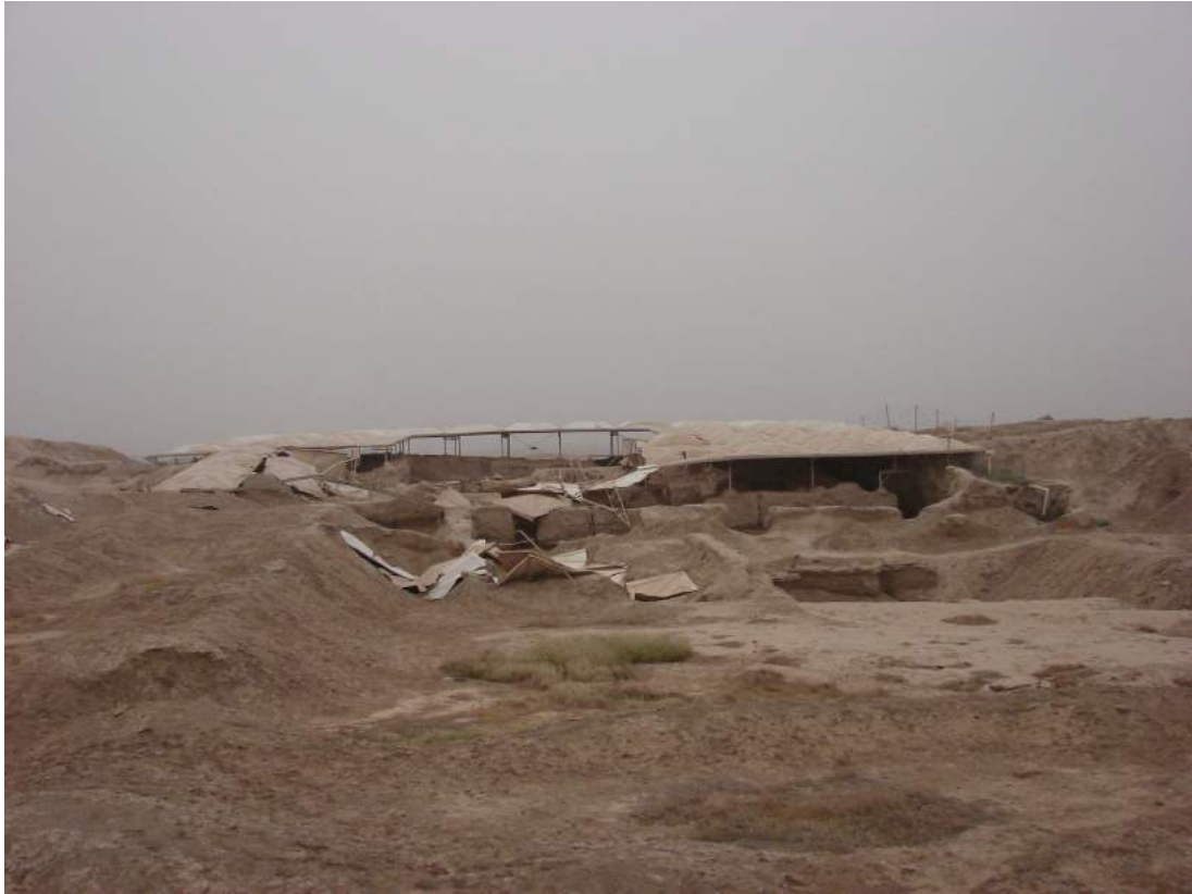
FIG. 14: Mari, palais de la ville II toiture endommagée, avril 2011, mission archéologique française de Tell Hariri-Mari.
