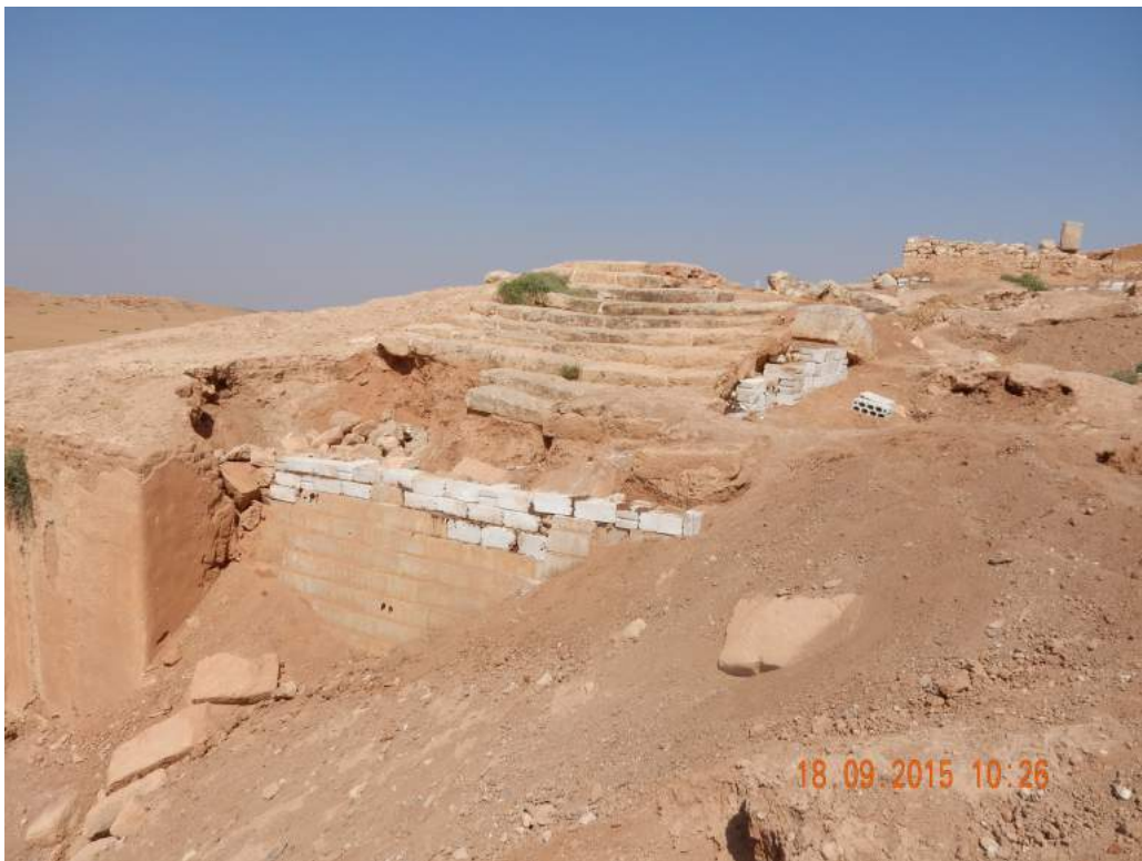
FIG. 15: Ebla : consolidation de l'escalier du palais G, avant et après notre intervention (© Idlib Antiquity Center).
