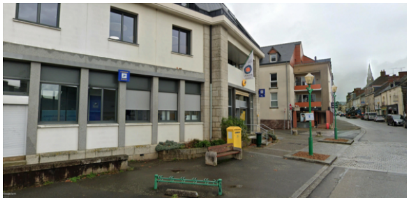
Photographie 3. La Canopée à Janzé (35), vue de la façade
