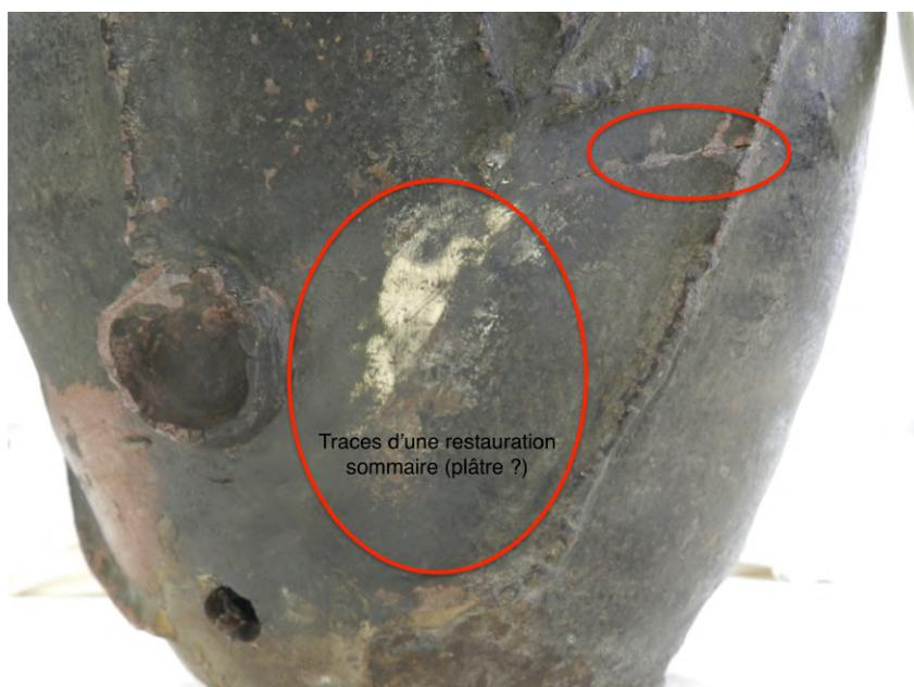
Fig. 9 - Fissure et traces de réparation de la fontaine
