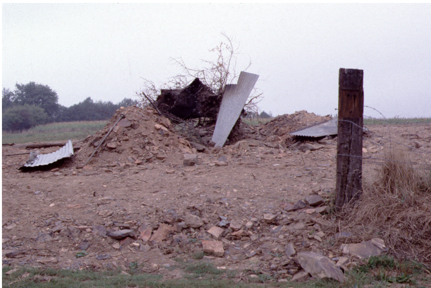
Fig. 2 - Les restes du four à pots de la Haute Louverie, état en juillet 1989
