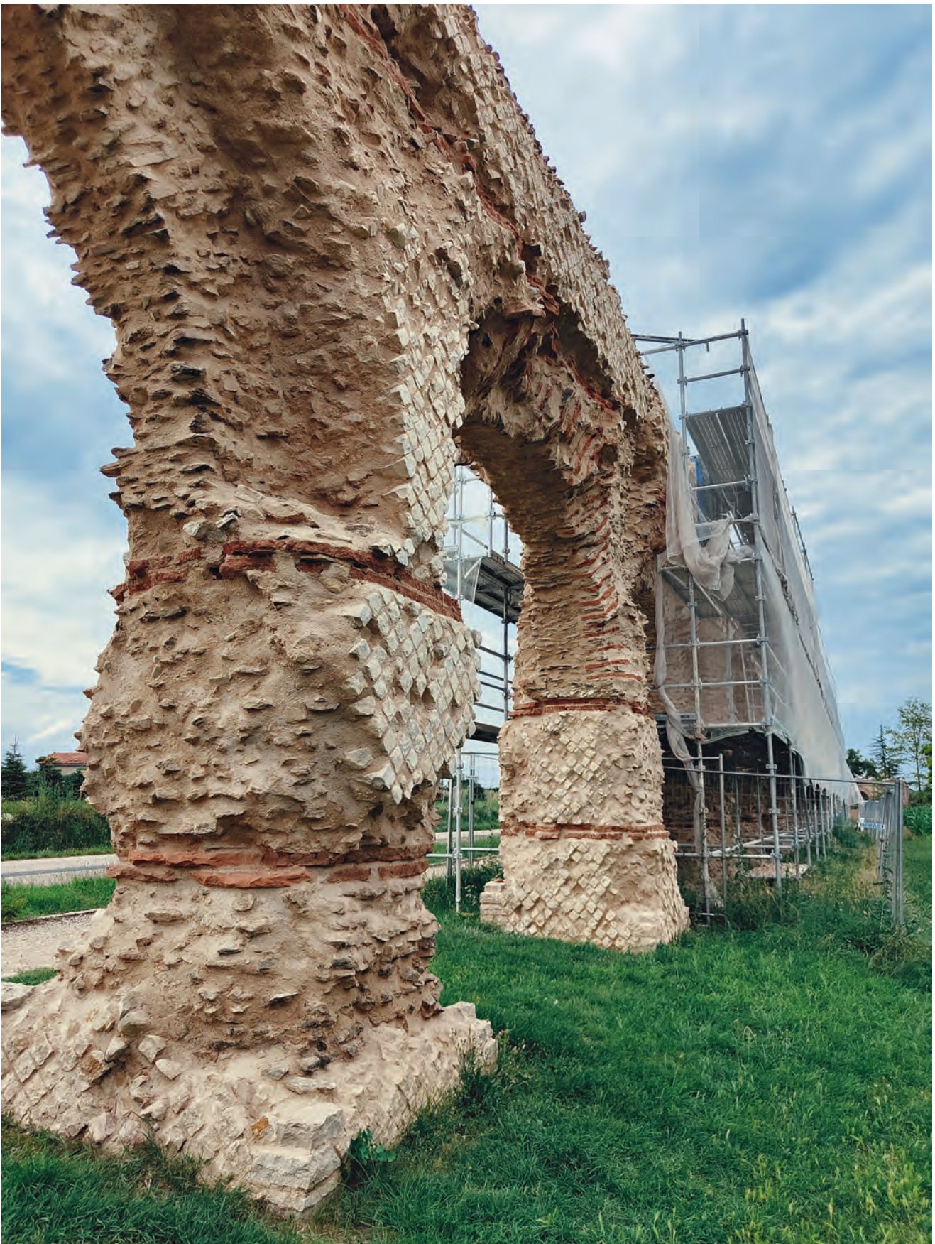
[ill. 5] L'aqueduc du Gier à Chaponost (Rhône). Ce chantier de fouille, entrepris à l'occasion de la restauration de la file d'arches du Plat de l'Air, a intégré l'examen du sommet des fondations, des éléments porteurs et du canal.
