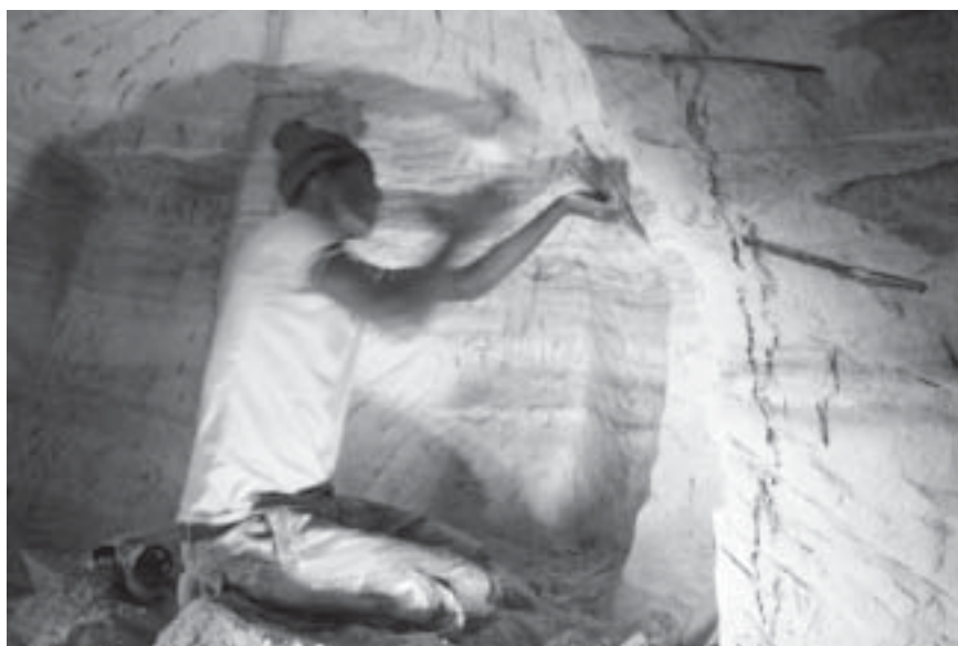
FIG. 3. Ouvrier à l'œuvre dans l'église en cours de creusement de Miḥilä Abunä Samu'el Hatsät.
