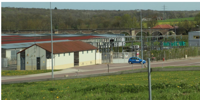
Photo3 : le poste-source de Vendeuvre sur Barse où sont situés les dispositifs numériques.
