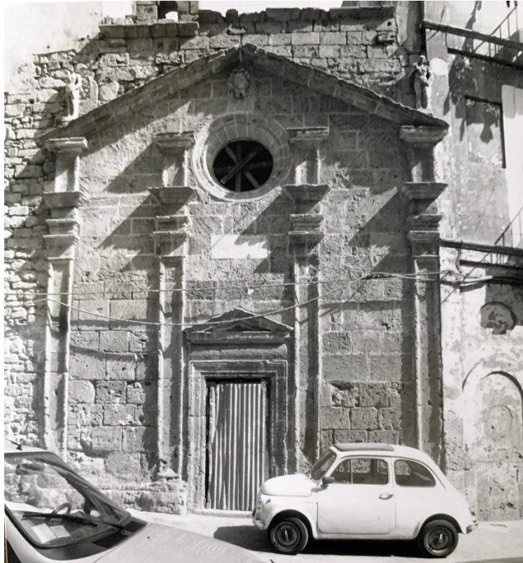
Fig. 13. Tarente, église Saint-André des Arméniens, façade ouest. Photo Gaiànè Casnati
