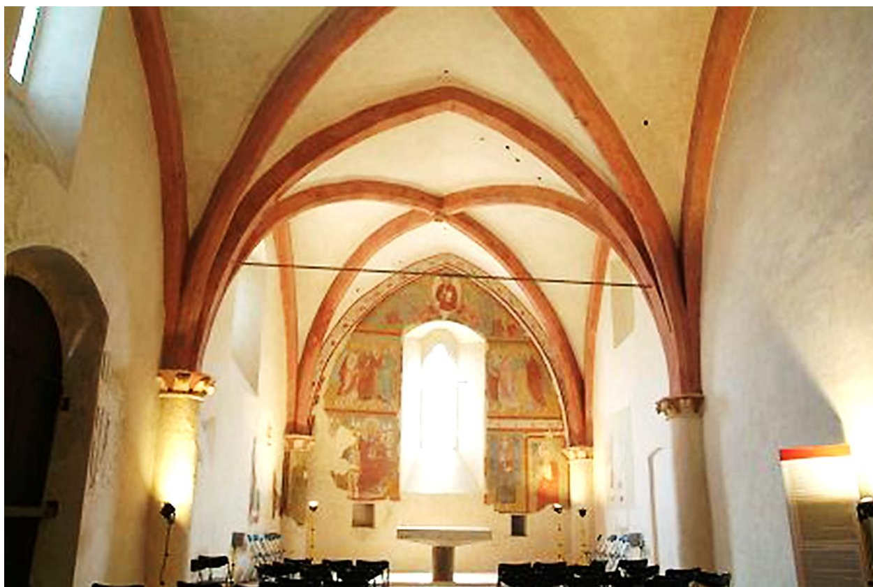
Fig. 16. Pérouse, église Saint-Matthieu des Arméniens. Vue intérieure vers l'abside. Photo en ligne fondazioneumbraarchitettura.it
