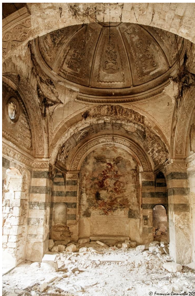
Fig. 4. Bari, église Saint-Georges des Martyrs. Vue intérieure vers l'abside. Photo en ligne Ferruccio Cornicello et www.famedisud.it/salviamo-la-chiesa-di-san-giorgio-martire
