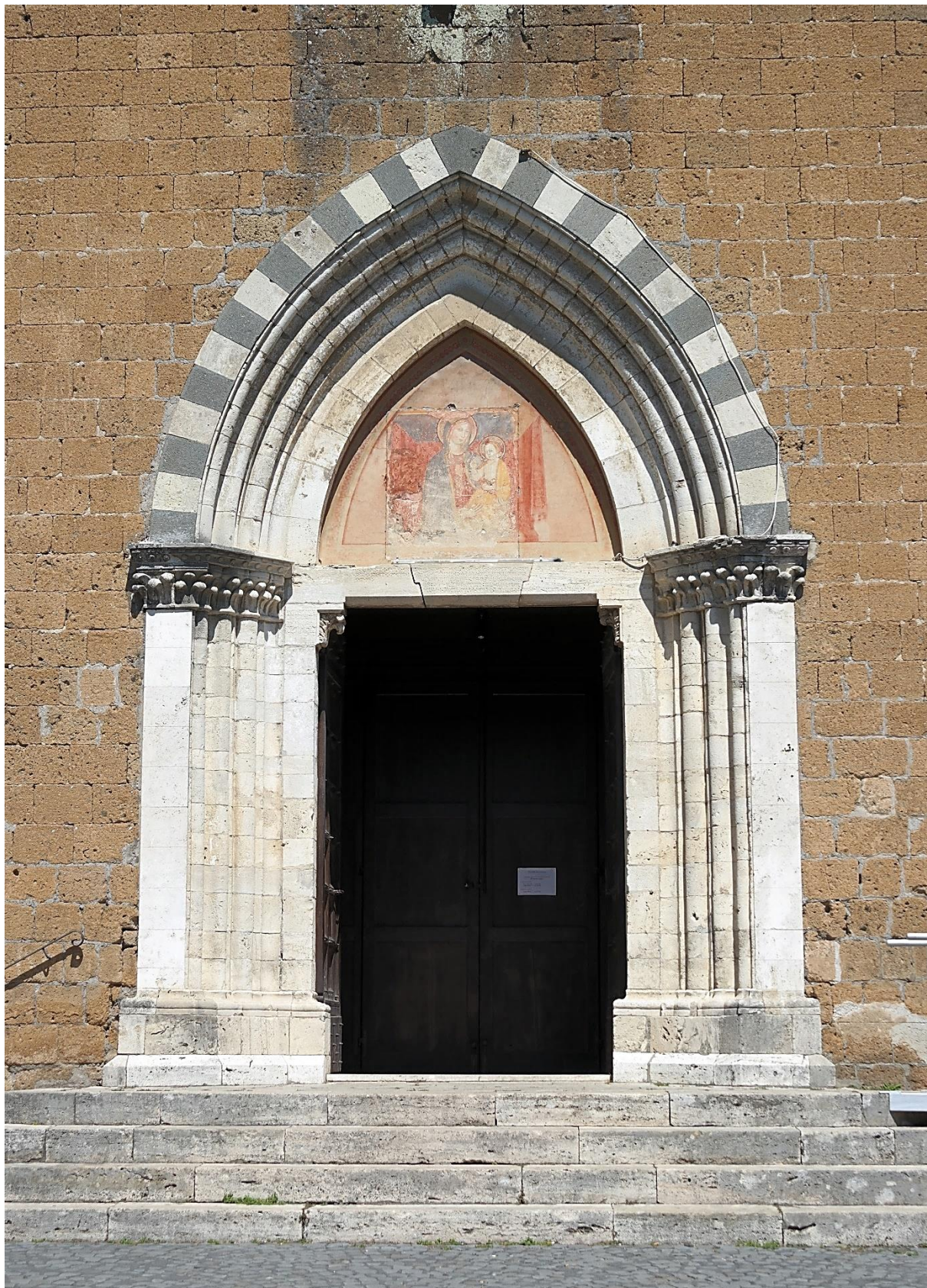
Fig. 21. Orvieto, église Saint-Dominique, face sud du transept. Portail provenant de l'église Saint-Esprit des Arméniens. Photo en ligne Luca Alessio et Wikimedia Commons
