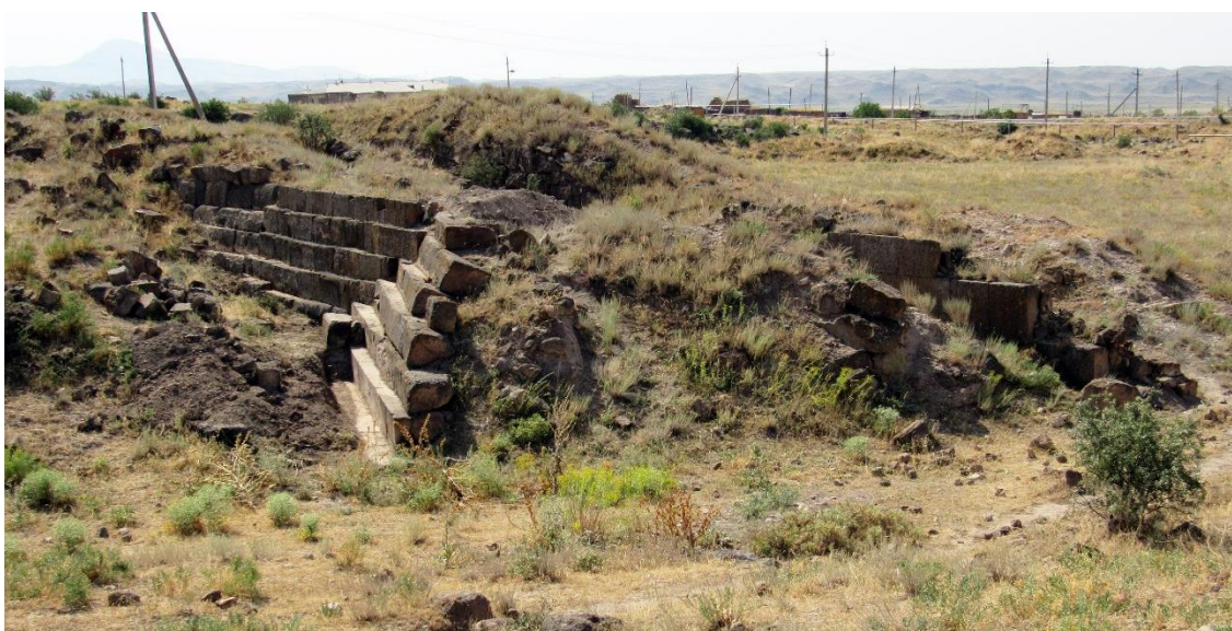
Fig. 42. Ereruyk, « barrage ». Face nord (amont) du troisième mur (à partir de l'aval). Vue du nord-ouest. Cliché P. Donabédian, LA3M, 2015.
