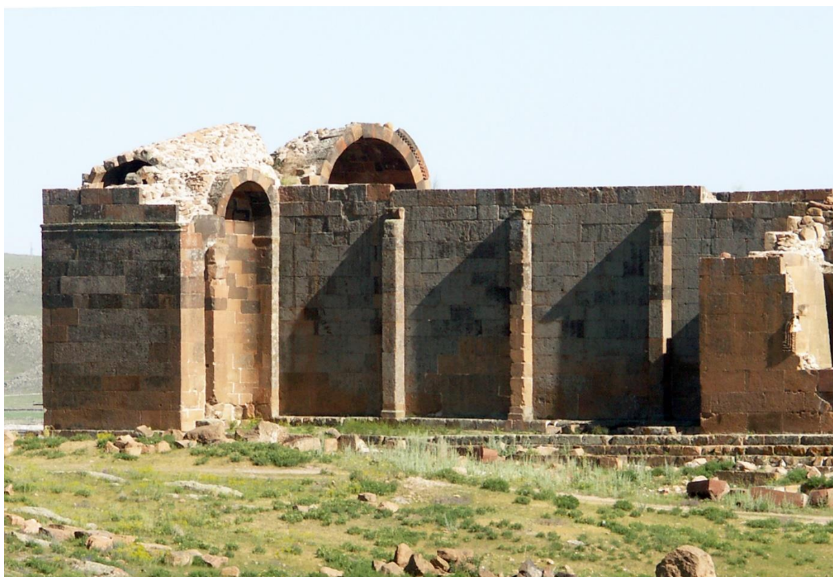
Fig. 7. Ereruyk, basilique. Façade nord vue du nord-ouest. Cliché P. Donabédian, LA3M, 2014.
