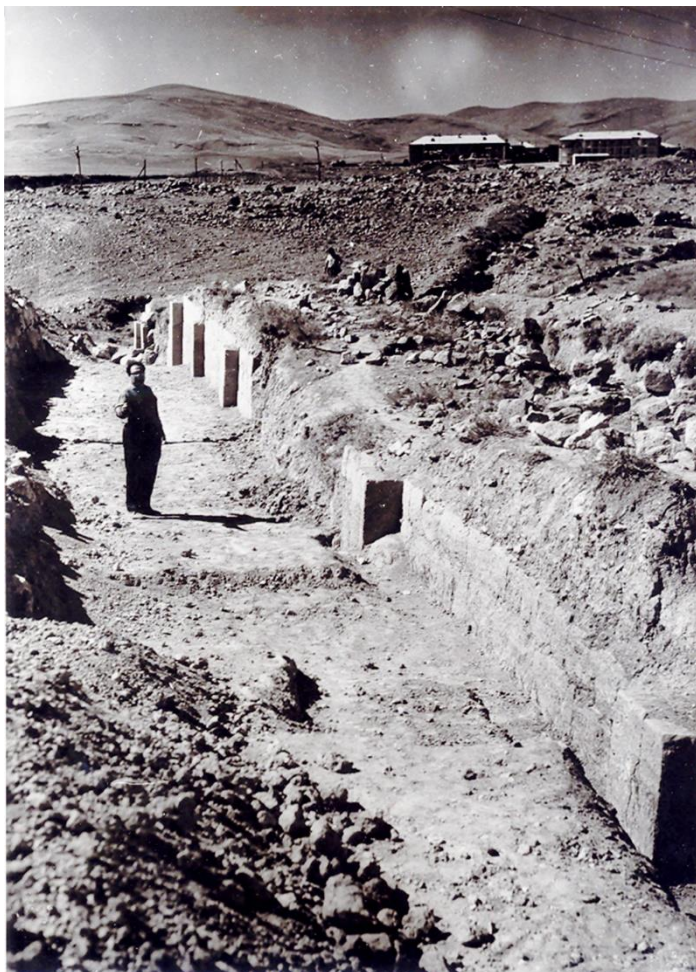
Fig. 40. Ereruyk, « barrage ». Dégagement du grand mur intermédiaire. Vue du sud-est. Campagne de 1958, dir. d'A. Sahinyan. Archives du Service de conservation des réserves et musées, Ministère arménien de la culture.
