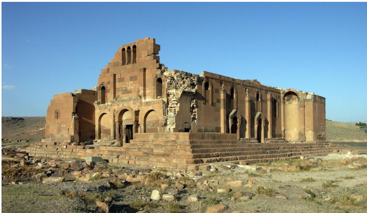
Fig. 3. Ereruyk, basilique. Vue générale du sud-ouest. Cliché P. Donabédian, LA3M, 2012.
