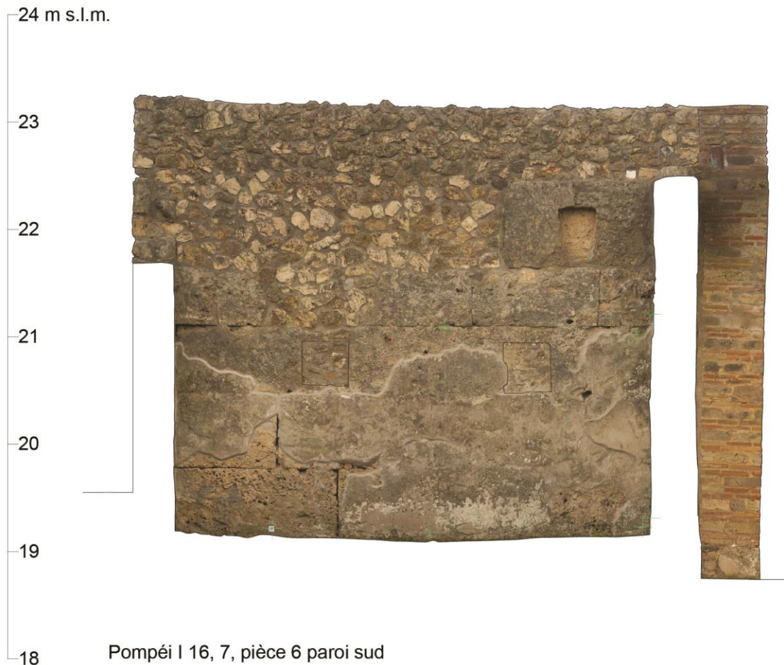
Fig. 11. Ortofoto della parete sud dell'ambiente (6-7), con indicazione delle finestre tamponate (G. Chapelin).
