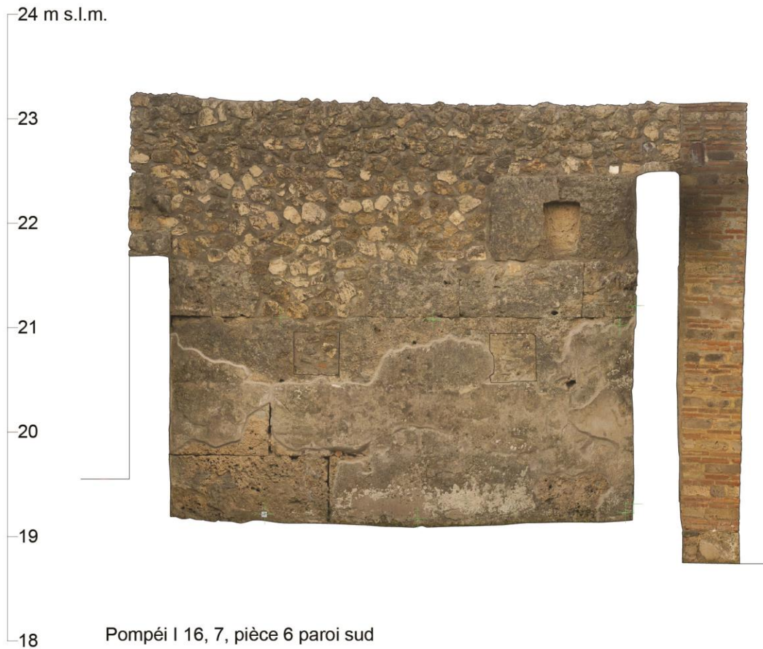
Fig. 11. Ortofoto della parete sud dell'ambiente (6-7), con indicazione delle finestre tamponate (G. Chapelin).
