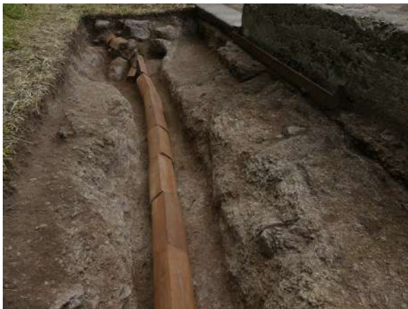
Fig. 373 : Série de chapeaux en terre cuite assurant la protection du réseau électrique au niveau du sondage 3C depuis le nord-ouest (photographie : M. Landolt).
