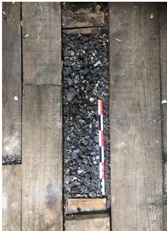
Fig. 254 : Scories isolantes dans le plancher des combles de la chambre à gaz (photographie : M. Landolt).
