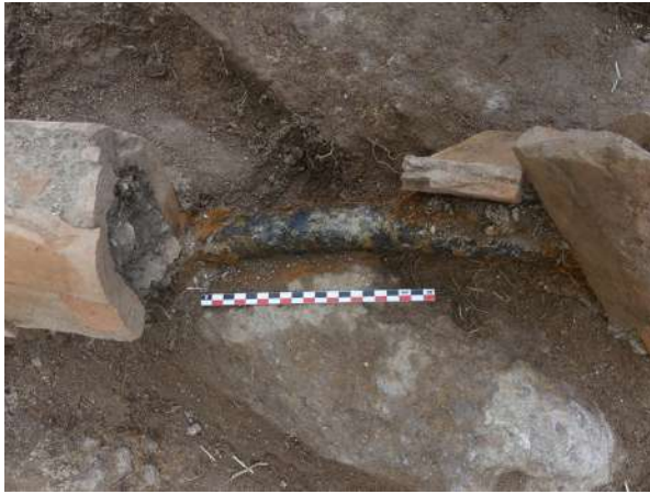
Fig. 371 : Détail du câble électrique au niveau du sondage 3C depuis le sud-est (photographie : M. Landolt).
