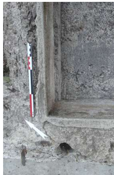
Fig. 245 : Détail du recouvrement de la plinthe bétonnée au niveau de l'angle ouest de la pièce 12 (US 4444 et 4445) (photographie : M. Landolt).
