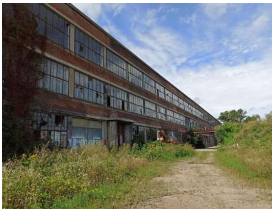
Fig. 311 : Vue générale de l'usine List (photographie : J. Brangé).
