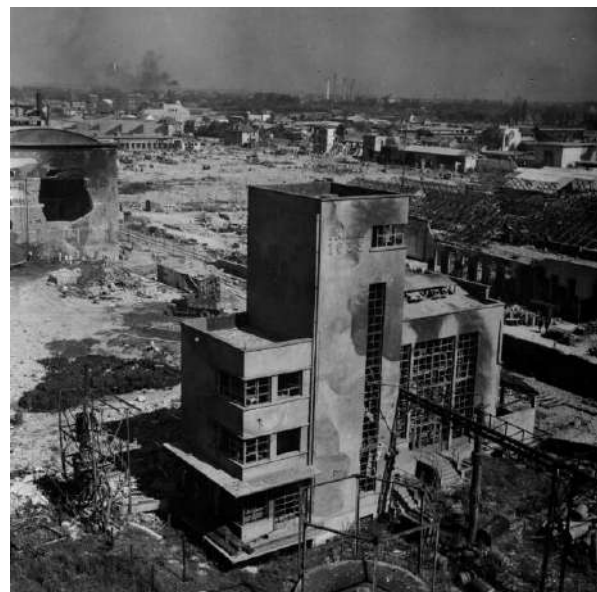
Fig. 303 : Vue des bâtiments du site Junkers de Strasbourg à l'arrière-plan après le bombardement du 27 mai 1944 (Seiler 2013, p. 148 ; Archives de la ville et de l'Eurométropole de Strasbourg, FI 102 86).
