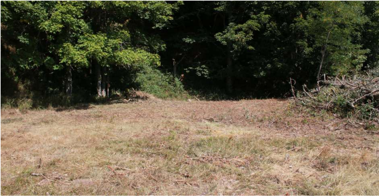
Fig. 507 : Débroussaillage de l'emplacement du compresseur (photographie : J. Brangé).
