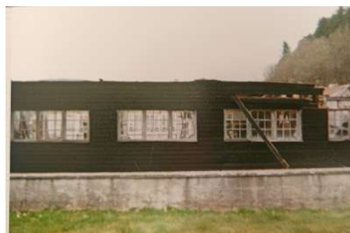
Fig. 69 : Halle n° 10 à Rothau en 1998 (photographie : Wendling Philippe).
