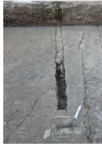
Fig. 387 : Alimentation électrique ELA 122.03 depuis le sud-est (photographie : M. Landolt).
