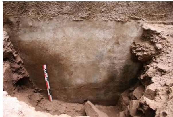
Fig. 267 : Enduit d'étanchéité (3406) du mur gouttereau NE (photographie : J. Brangé).
