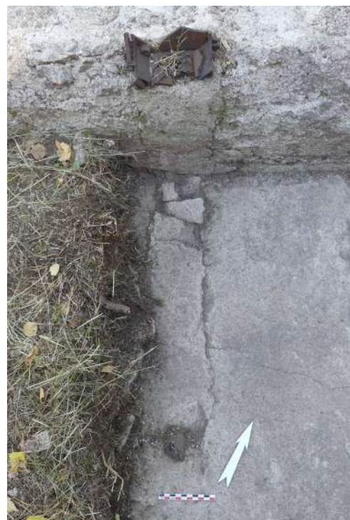
Fig. 390 : Alimentation électrique ELA 122.14 depuis le sud-est (photographie : M. Landolt).
