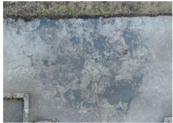
Fig. 379 : Traces de toile goudronnée fondue ou de goudron sur la dalle de la halle 122 depuis le dessus (photographie : M. Landolt).
