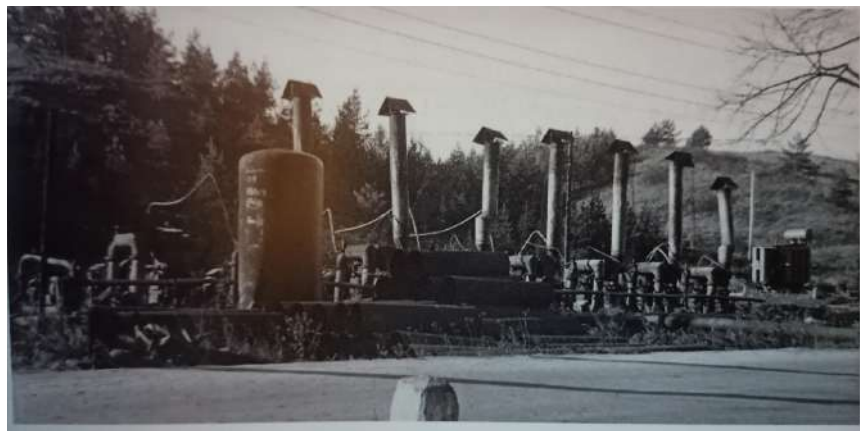
Fig. 513: Compresseur du chantier Jonastal près de Amstadt (Stadler et al. 2021, p. 71, Archiv Gedenkstätte Buchenwald ).
