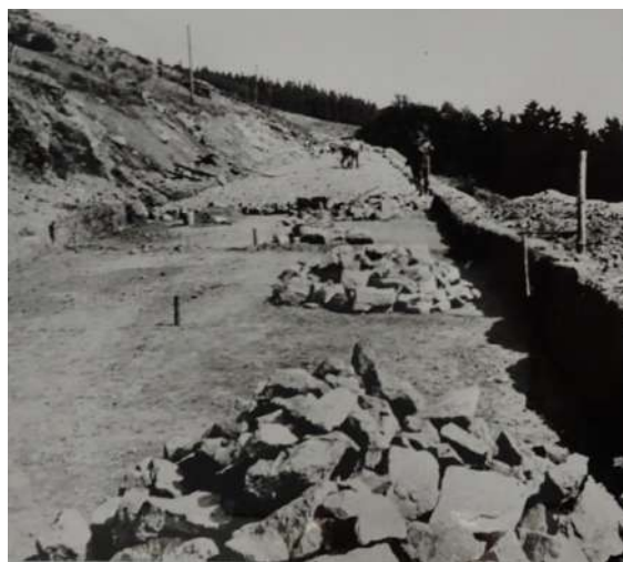
Fig. 27 : Construction de la route menant à la carrière pour les civils et les livraisons de matériaux, vers 1941 (NATZ19_PH_ARCH_245, CERD).
