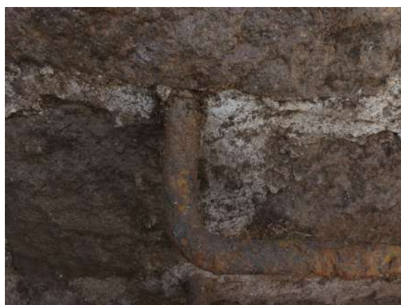
Fig. 477 : Détail du scellement de l'échelle, ELA 23 (photographie : J. Brangé).
