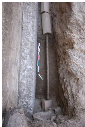
Fig. 211 : Réseau électrique sans ses chapeaux en terre cuite (photographie : L. Aymard et J. Brangé).
