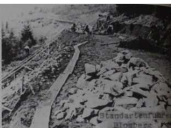
Fig. 84 : Construction de la route des ouvriers civils vers la carrière vers 1941 (NATZ19_PH_ARCH_398, CERD).
