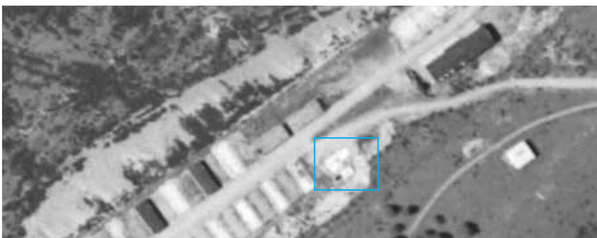
Fig 501 : Photographie aérienne de la carrière en 1950 ; compresseur encadré en bleu (NATZ19_PH_ARCH_336, IGN).
