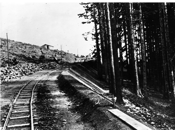
Fig. 81 : Construction de la route des ouvriers civils vers la carrière vers 1941 (CERD).
