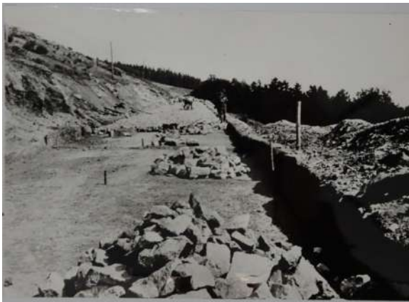
Fig. 79 : Construction de la route des ouvriers civils vers la carrière (?) vers 1941 (NATZ19_PH_ARCH_245, CERD).
