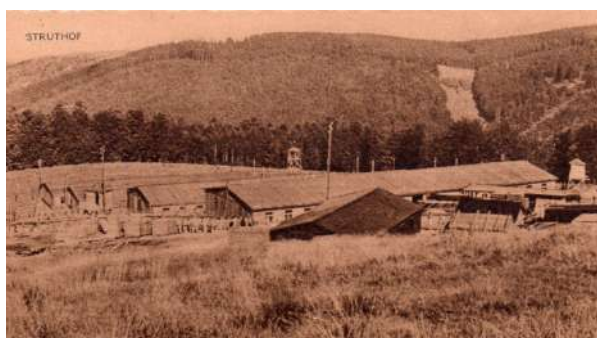
Fig. 28 : Vue de la construction du camp haut au début de l'année 1942 par les déportés (NATZ19_PH_ARCH_002, carte postale édition Lucien Kohler, CERD).
