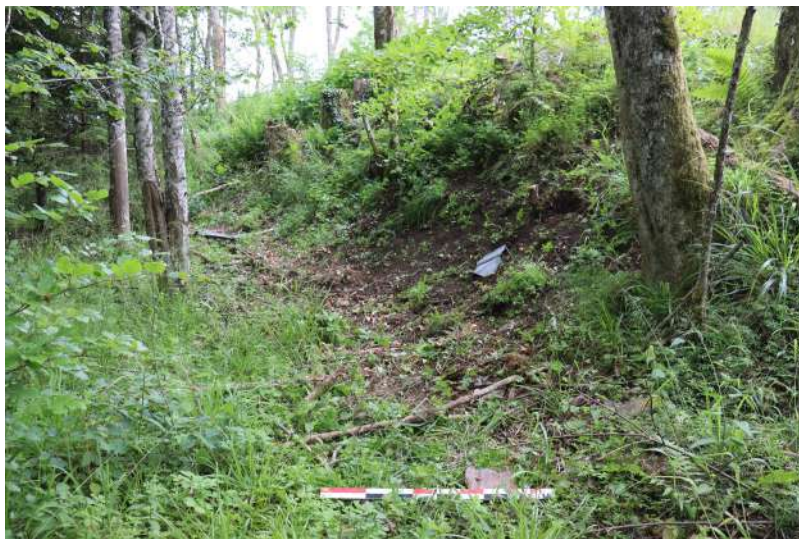
Fig. 172 : Talus du bâtiment garage, juin 2022 (photographie : J. Brangé).
