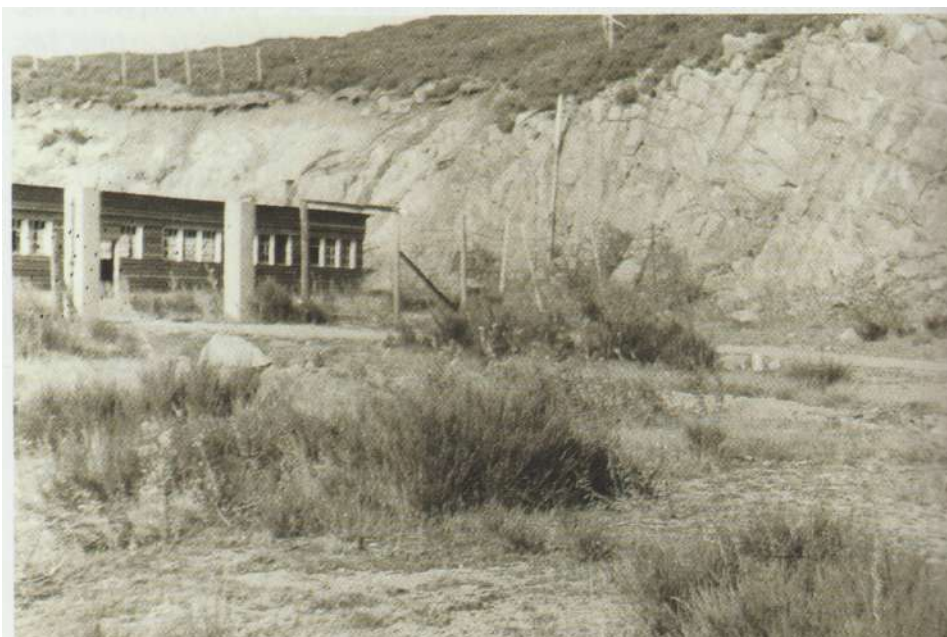
Fig. 403 : Entrée SE de la carrière vers 1947 (Collection Charles René, CERD).
