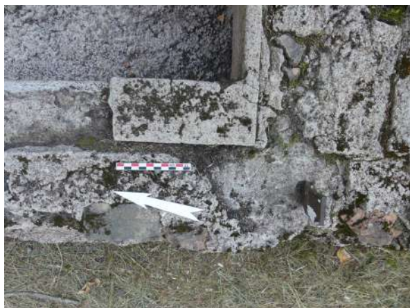
Fig. 252 : Détail du recouvrement de la plinthe bétonnée au niveau de l'angle nord de la pièce 12 (US 4443 et 4444) (photographie : M. Landolt).
