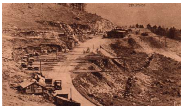
Fig. 29 : Exploitation de la carrière au printemps 1942. On peut remarquer les rampes d'évacuations des déchets de taille (NATZ19_PH_ARCH_001, carte postale édition Lucien Kohler, CERD).
