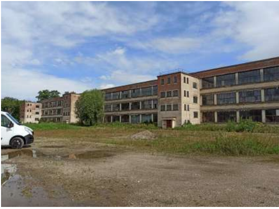
Fig. 310 : Vue générale de l'usine List (photographie : J. Brangé).
