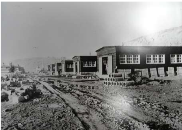
Fig. 318 : Carrière au printemps 1943. Toutes les halles du côté ouest ne sont pas encore construites (NATZ19_PH_ARCH_014, CERD).
