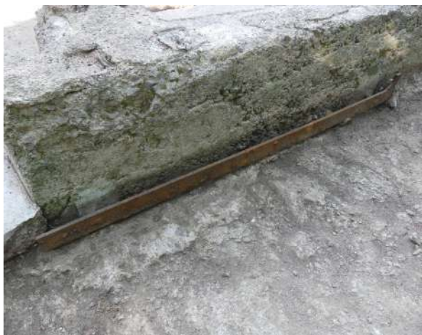
Fig. 358 : Rail inférieur du vantail gauche coulissant du portail arrière de la halle (US 3340) depuis le nord-est, SD3C (photographie : M. Landolt).
