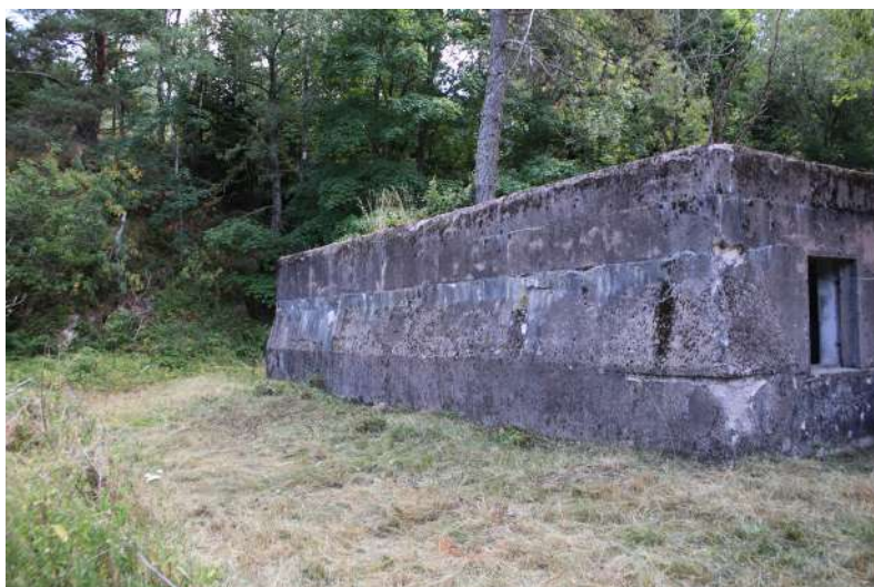
Fig. 213 : Pignon NO avec son système de contrefort, avant la fouille (photographie : L. Aymard et J. Brangé).
