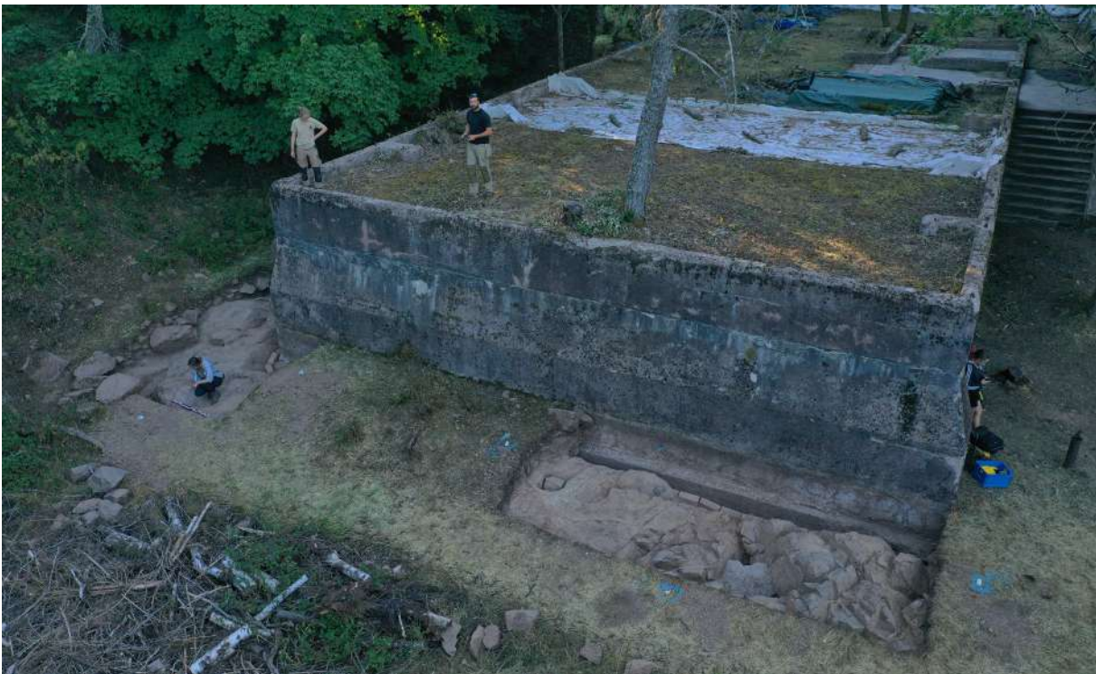
Fig 217 : SD1A et SD1B, le long du mur pignon NO de la forge (photographie : A. Vantillard).
