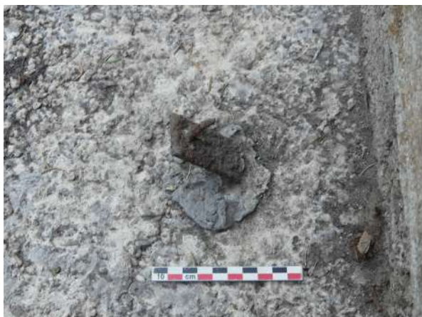
Fig. 246 : Détail d'une patte de fixation métallique (US 3464) (photographie : M. Landolt).
