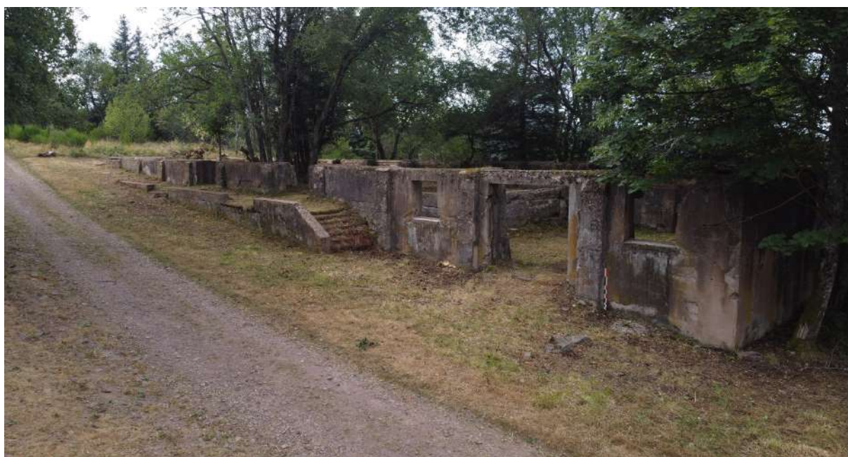
Fig. 138 : Vue du bâtiment dépôt (photographie : A. Vantillard).
