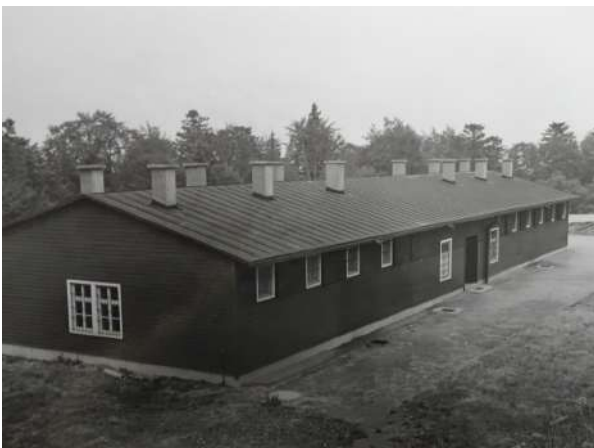
Fig. 519 : Bunker en 1976, gouttereau sud (NATZ19_PH_ARCH_194, CERD).
