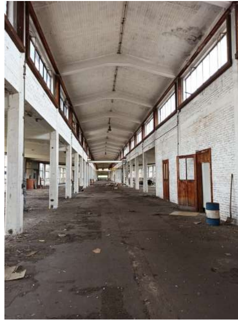
Fig. 313 : Intérieur (étage) de l'usine List (photographie : J. Brangé).
