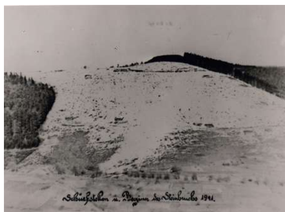
Fig. 78 : Sondages géologiques et début de la carrière en 1941 ( Schurfstellen u. Beginn des Steinbruchs 1941 ) (NATZ19_PH_ARCH_100, CERD).
