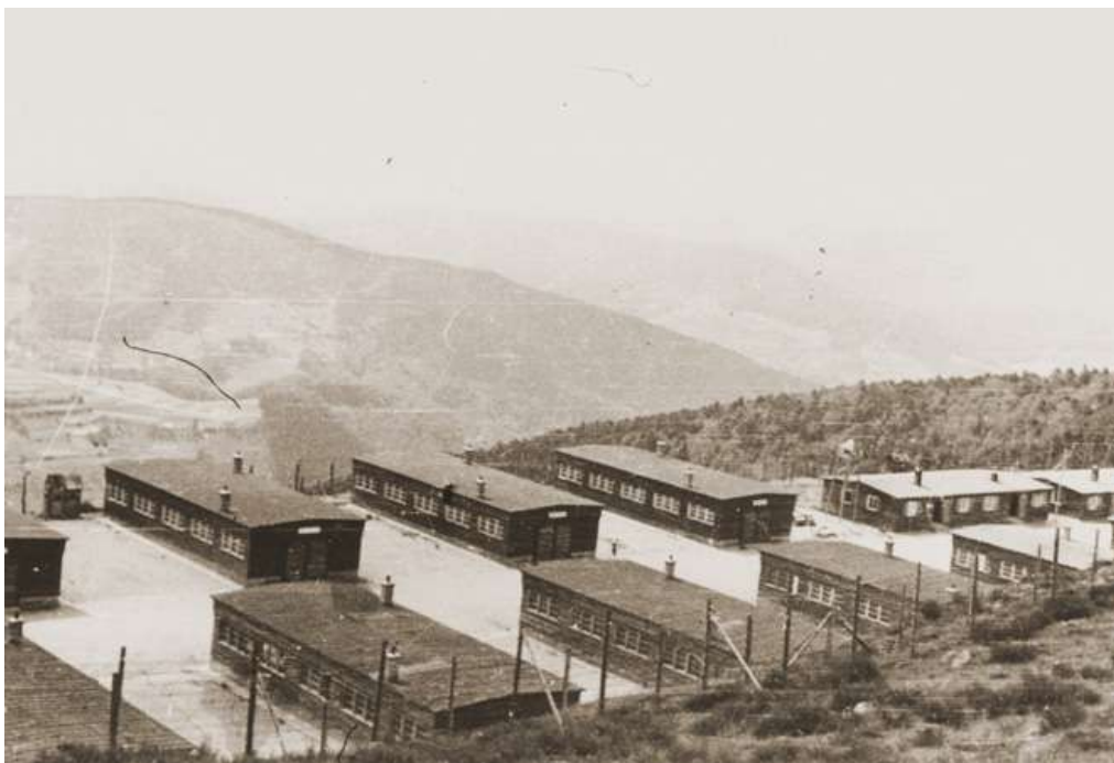
Fig. 408 : Vue générale des halles de la carrière vers fin 1944/début 1945 (NATZ19_PH_ARCH_096, CERD et USHMM).
