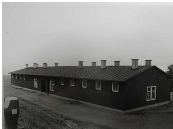
Fig. 518 : Bunker en 1976, gouttereau sud (NATZ19_PH_ARCH_211, CERD).
