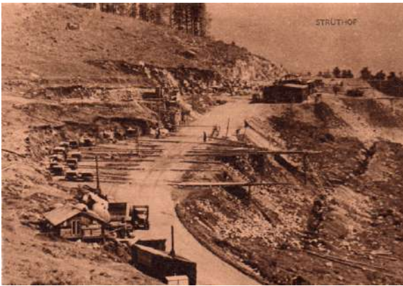
Fig. 316 : Carrière au printemps 1942. Aucune halle n'est construite (NATZ19_PH_ARCH_001, CERD).
