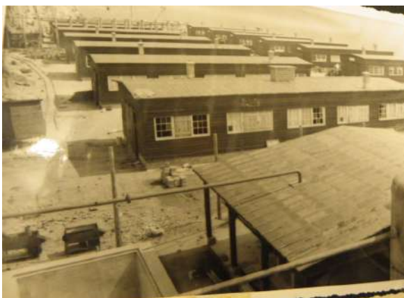
Fig. 98 : Halles et compresseur après-guerre (Collection particulière).
