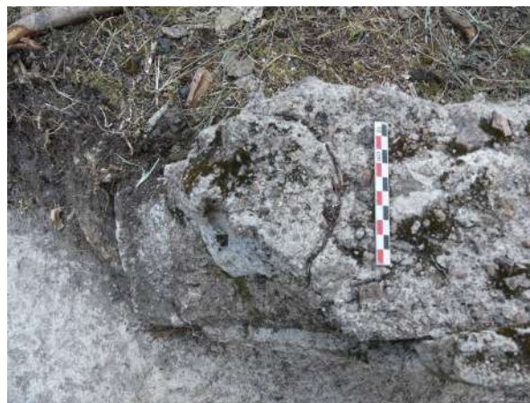
Fig. 236 : Vue du dessus de l'évidement au sud-ouest de l'ouverture entre la pièce 12 et 14 (photographie : M. Landolt).
