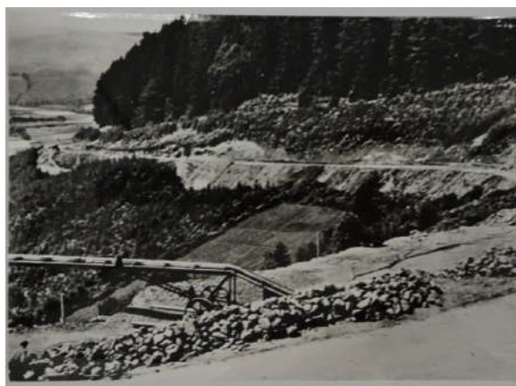
Fig. 82 : Construction de la route des ouvriers civils vers la carrière et création de la terrasse artificielle vers 1941 (NATZ19_PH_ARCH_244, CERD).
