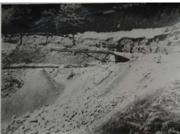
Fig. 83 : Construction de la route des ouvriers civils vers la carrière et création de la terrasse artificielle vers 1941 (NATZ19_PH_ARCH_175, CERD).
