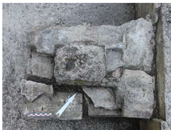
Fig. 238 : Vue de la base du conduit de cheminée depuis le dessus (US 3450, 3452 et 3481) (photographie : M. Landolt).
