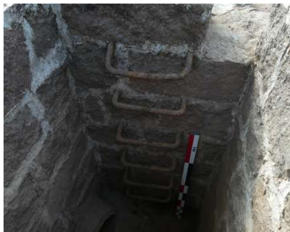
Fig. 475 : Echelle métallique à l'intérieur du regard, ELA 23 (photographie : J. Brangé).
