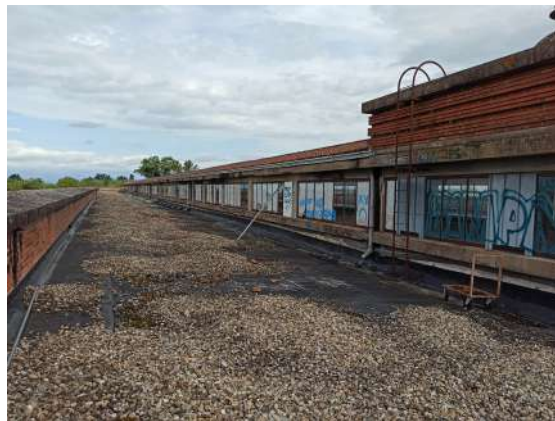
Fig. 312 : Toit de l'usine List (photographie : J. Brangé).
