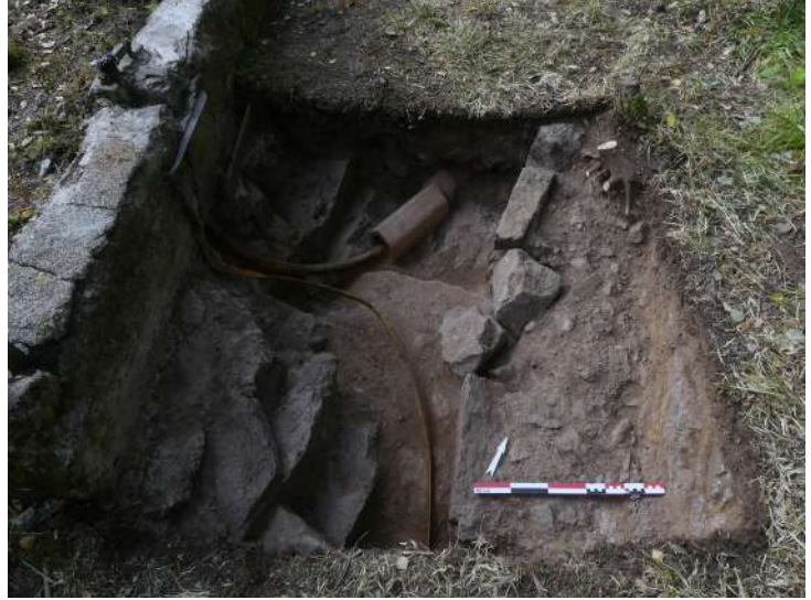
Fig. 370 : Tranchée de réseau électrique au niveau du sondage 3D depuis le sud-est (photographie : M. Landolt).
