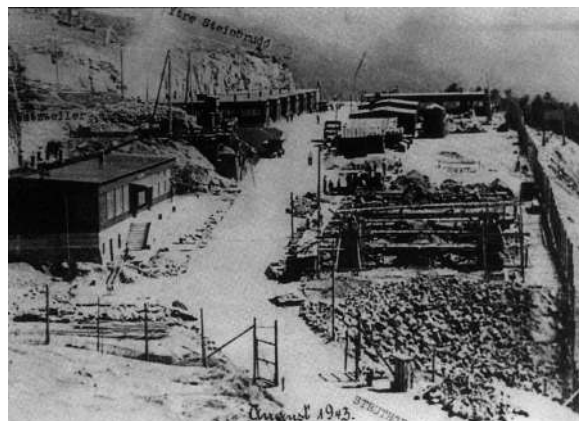
Fig. 31 : Cliché de la construction de la baraque dépôt en août 1943 (NATZ19_PH_ARCH_093, CERD).
