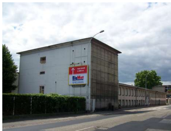
Fig. 305 : Abris anti-aériens et usine du site Junkers de Strasbourg (photographie : M. Landolt).
