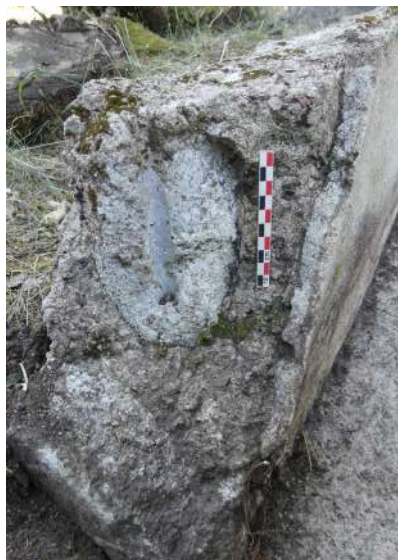
Fig. 243 : Vue de profil l'évidement au sud-ouest de l'ouverture entre la pièce 12 et 14 (photographie : M. Landolt).
