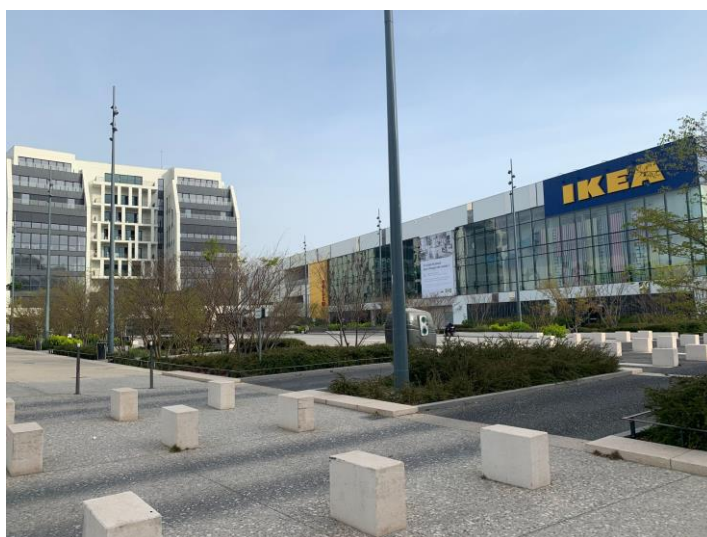
Figure 6 : Le nouveau quartier du Grand Parilly, Vénissieux
