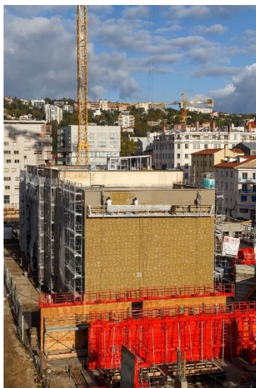
Figure 38 : Opération de surélévation réalisée par l'entreprise Pierres Construction
