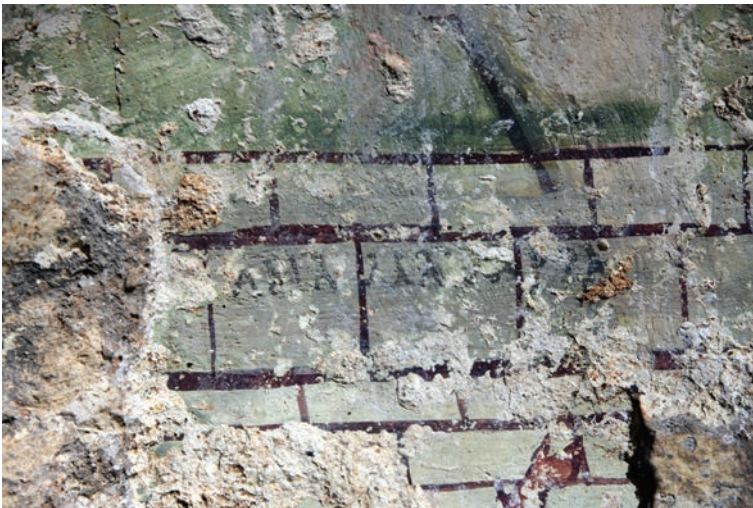
Fig. 84 – Paroi nord, tableau du chantier : inscription 63 (© CNRS Hisoma 2019).
