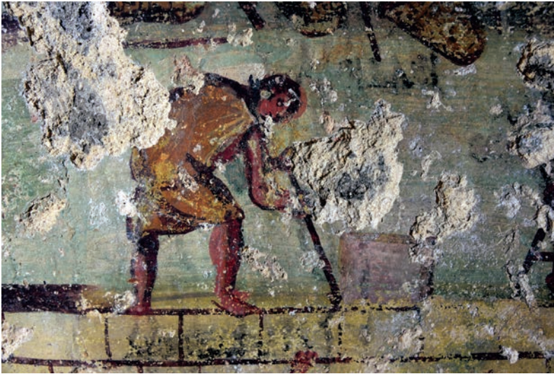
Fig. 19 – Paroi ouest, tableau du chantier : scène de maçonnerie et inscription 9 (© CNRS Hisoma 2019).
