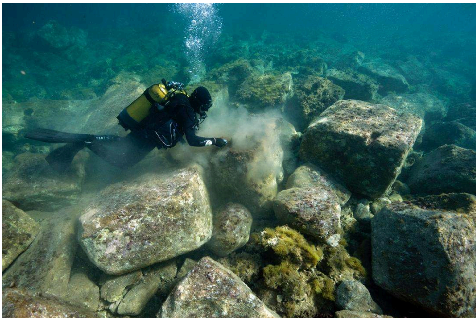
Fig. 6 : Vue sous-marine d'un opérateur durant les opérations de nettoyage manuel des blocs
