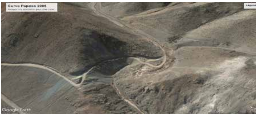
Figura 10: Curva de Paposo en 2005, durante las obras del Cuerpo Militar del Trabajo. Fuente: Google Earth (2023b).
