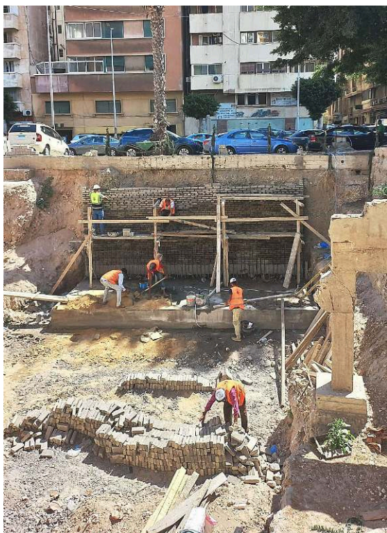
Fig. 48. Tabiyet Nahassin. Mise en place du mur de chemisage, préalable au coulage du mur de béton (K. Machinek).
