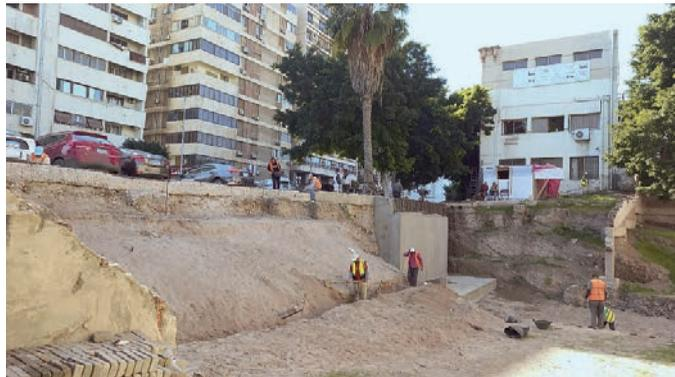
**Fig. 5.2.** Tabiyet Nahassin. Mise en place d'un remblai de sable tassé le long de la parcelle entre le dépôt archéologique et la rue Sultan-Hussein. Cliché: K. Machinek. © Archives CEALex.
