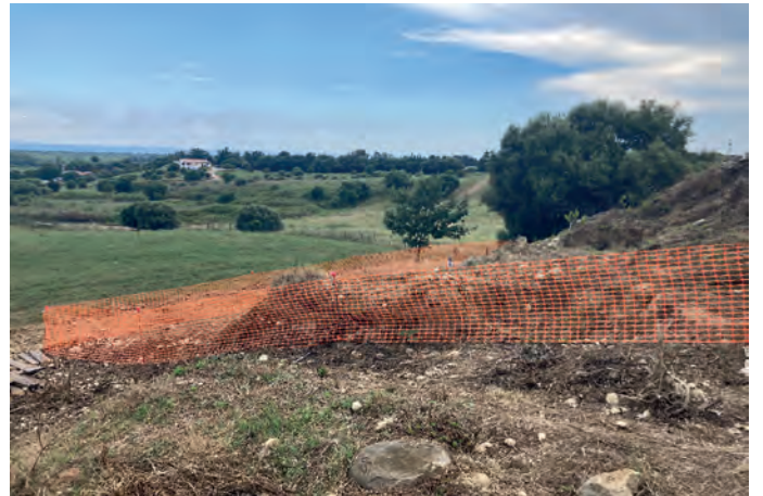
Balisage de la façade Est / Nord-Est du secteur de l'amphithéâtre
