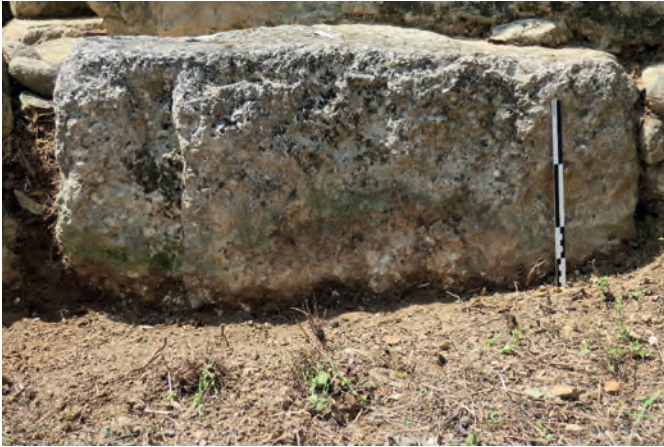
Fig. 25 : Courtine RMP 2074 (MR2074), le bloc en calcaire coquillier Us 2074b, face nord (photo : P. Fontaine)
