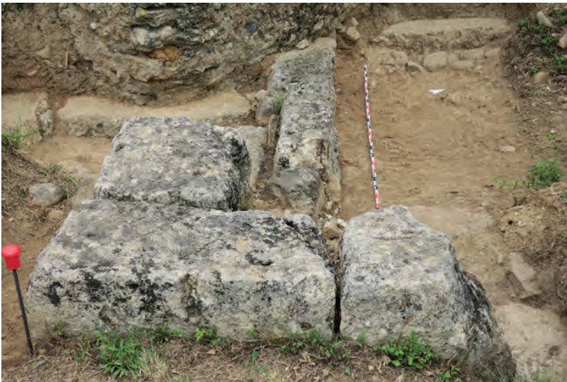
Fig. 17 : Courtine RMP2074, parement extérieur MR2122 (Us 2122) (photo : P. Fontaine)
