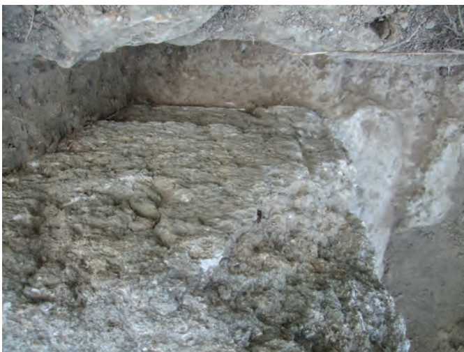
Fig. 21 : Courtine RMP2074, parement intérieur (MR2075), détail de la face de parement du bloc Us 2075c. Reste de la ciselure d'encadrement vue de haut (photo : P. Fontaine)
