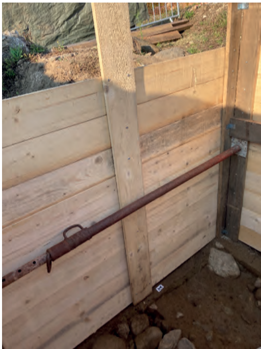
Mise en place des étais dans le caisson de palplanches du sondage de la Zone 1
