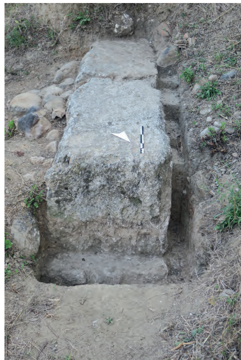
Fig. 19 : Courtine RMP2074. Le parement intérieur (MR2075), vu de l'extrémité nord (photo : P. Fontaine).
