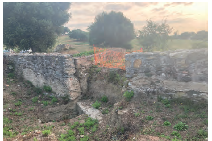
Balisage à l'intérieur de l'amphithéâtre (ouverture depuis l'extérieur sur le sondage Inrap de 2020)
