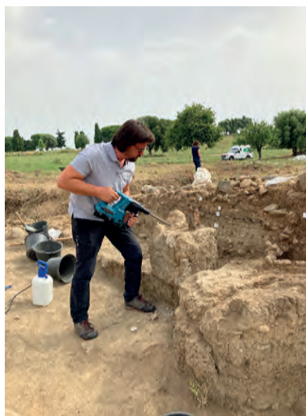
Zone 4 : démontage d'un plot de béton (support de la couverture en amiante réalisée en 1979) situé dans l'emprise de la fouille 2023
