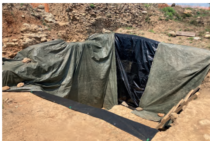
Mise en place de bâches de protection en fin de fouille dans le sondage de la Zone
