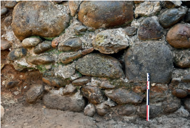
Fig. 58 : Vue de détail, depuis le sud, de la partie inférieure du mur MR3145, de la limite entre la partie fondée de ce mur et de l'élévation. (photo : J. Bertaut)
