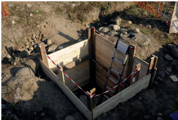
Mise en place du caisson de palplanches dans le sondage de la Zone 1
