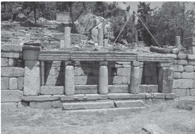
Fig. 109 : La fontaine centrale à colonnade après les opérations de restauration (O. Henry).
