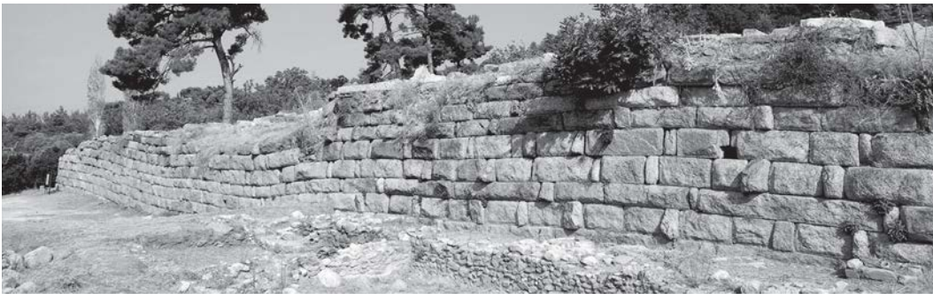
Fig. 4 : Vue générale du mur de soutènement sud de Labraunda, depuis l'Est (Fr. Marchand- Beaulieu).
