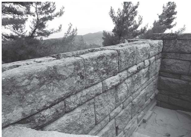
Fig. 48 : Appareil à carreaux et panneresses, Tour Pentagonale (B. Vergnaud).
