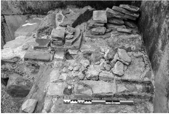
Fig. 11 Pièce sud des Oikoi, surface du pilier sud-ouest, avant le nettoyage et la restauration, vue depuis le nord (Görkem Çimen).
