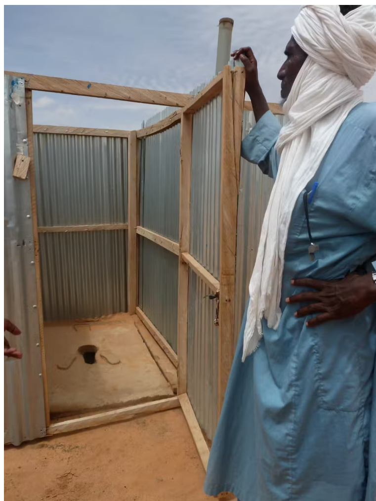
Letrina instalada en el campo de refugiados de Abala, Níger. Debido a las dificultades para acceder al agua, las letrinas rara vez se limpiaban, sino que se bloqueaban una vez llenas y luego se trasladaban. Alice Corbet, agosto de 2014, Fourni par l'auteur
