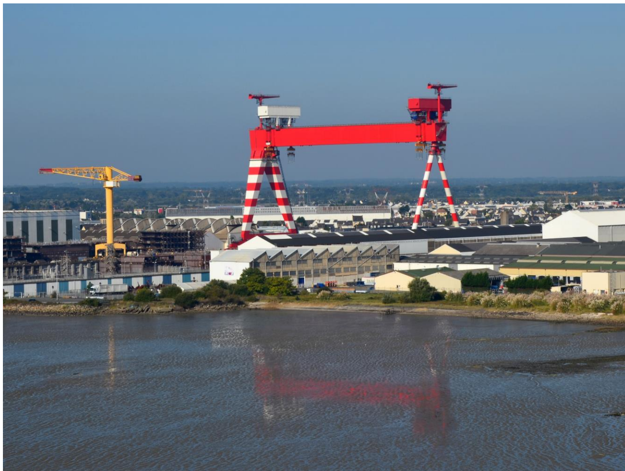
Photographie 2 : Le très grand portique sur les chantiers navals de Saint-Nazaire (crédit : Andrea Klose)
