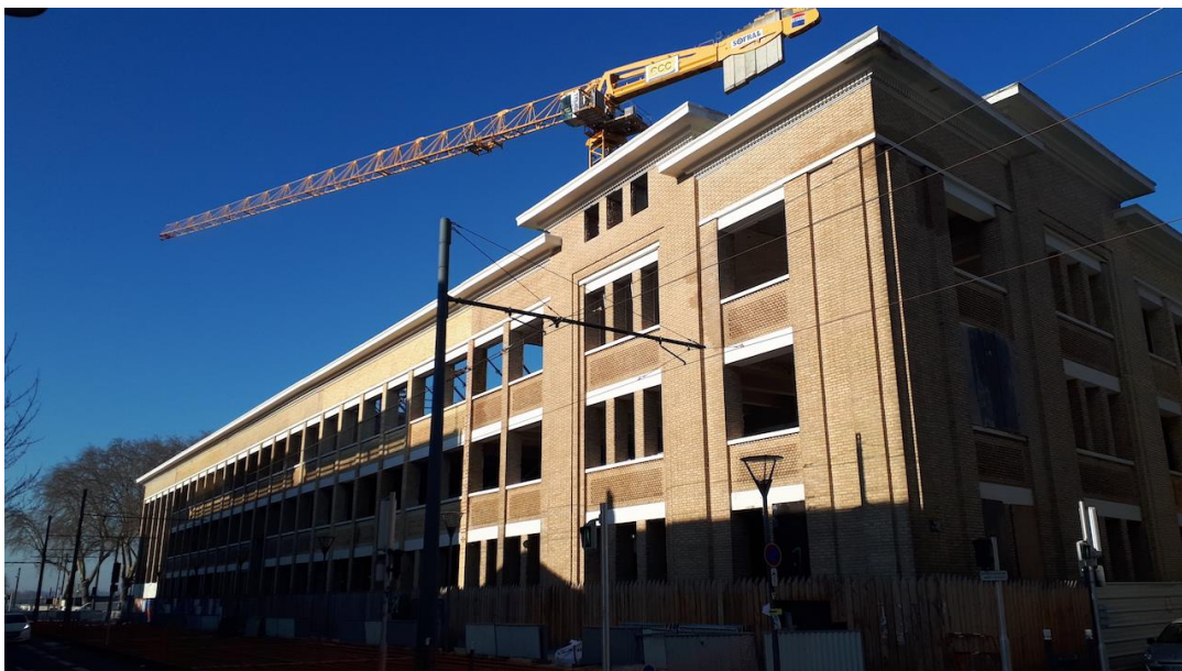
Photographie 4 : ancienne usine Cointreau des Luisettes en pleine transformation avec surélévation sur 3 niveaux (crédit : Arnaud de Lajartre)
