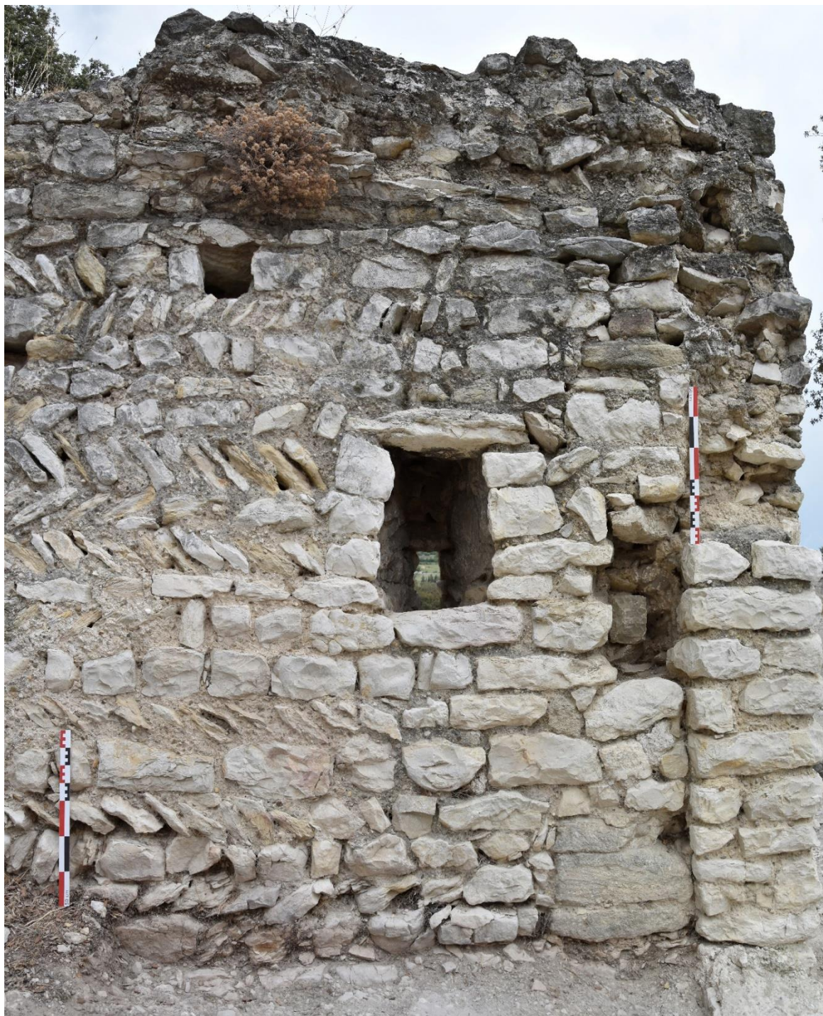
Fig. 29 : Vue de l'archère dans le mur 185 et négatifs de l'arc de la porte et de la voûte de l'entrée 2 (Olivier Thuaudet).
