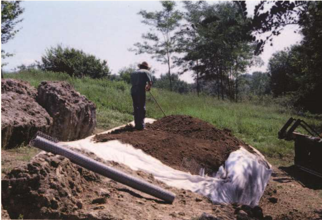
Aménagement paysager du site : Protection des parements par une couverture végétale sur géotextile
