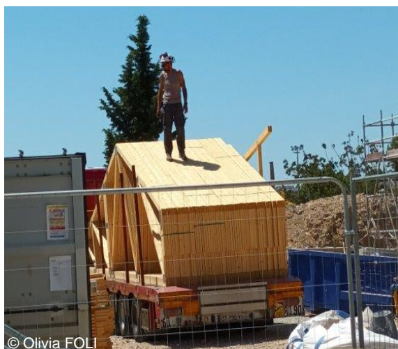
Charpentier réceptionnant des éléments d'ossature bois.
