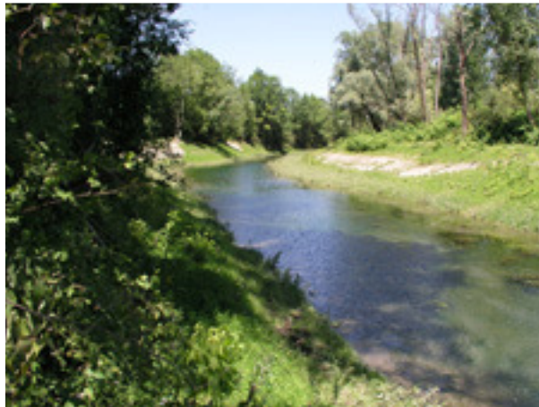
Figure 3.1.2 Lône de la Malourdie après restauration
