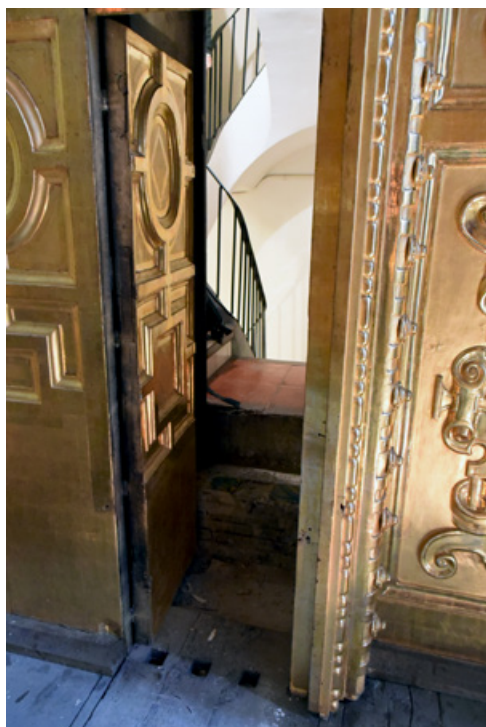
Fig. 4. Retable du RCSCC, porte latérale de la niche du retable
