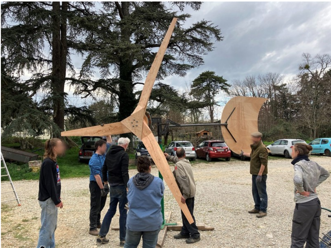
Figure 3 : éolienne en drapeau lors du montage - Source : photo personnelle
