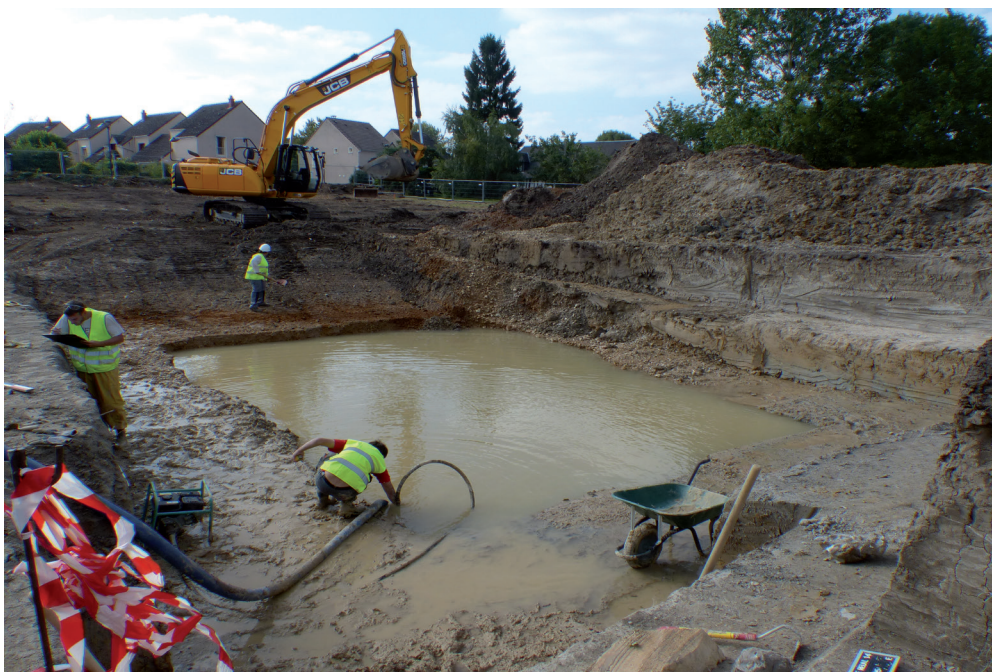
N° 1 : Décapage à la pelle mécanique suivant deux paliers de sécurité pour atteindre le fond de la dépression
