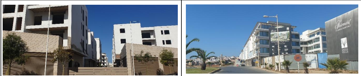
Fig. 3&4 : Vues des unités de la CAM en arrêt depuis 2014 et du chantier de l'hôtel Fairmont sur l'avenue Fés en face de la Kasbah des Oudayas. Source : photos de l'auteur.
