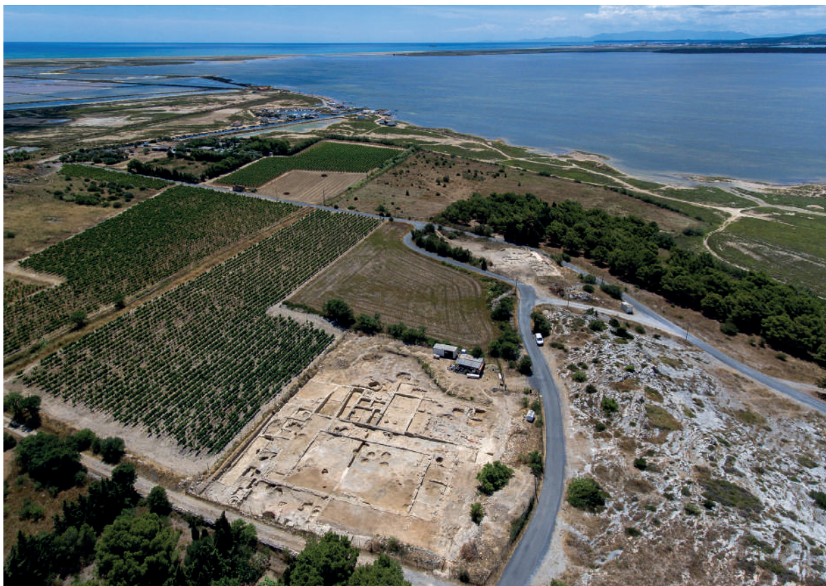
Fig. 7. Vue générale du site de Saint-Martin à Gruissan (© P. Benoist).
