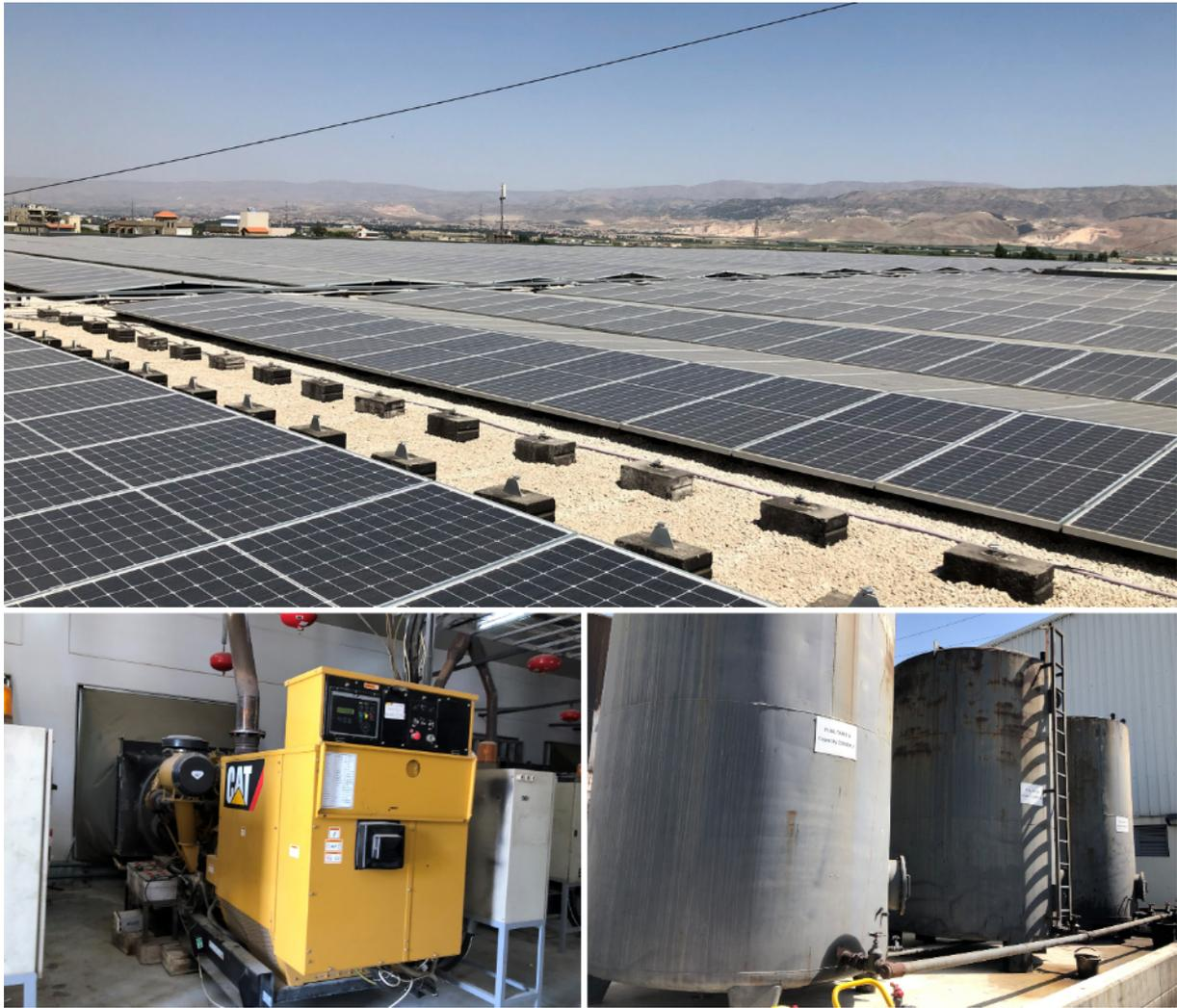
21. L'entreprise agroalimentaire de Daher Food articulant panneaux photovoltaïques (1,5 MW) et générateurs diesel (4 MW et cuves de fioul), et jouant d'une double connexion au réseau local de la concession d'électricité de Zahlé, ainsi qu'au réseau national libanais. Zahlé, Liban (Alix Chaplain, 2021)
