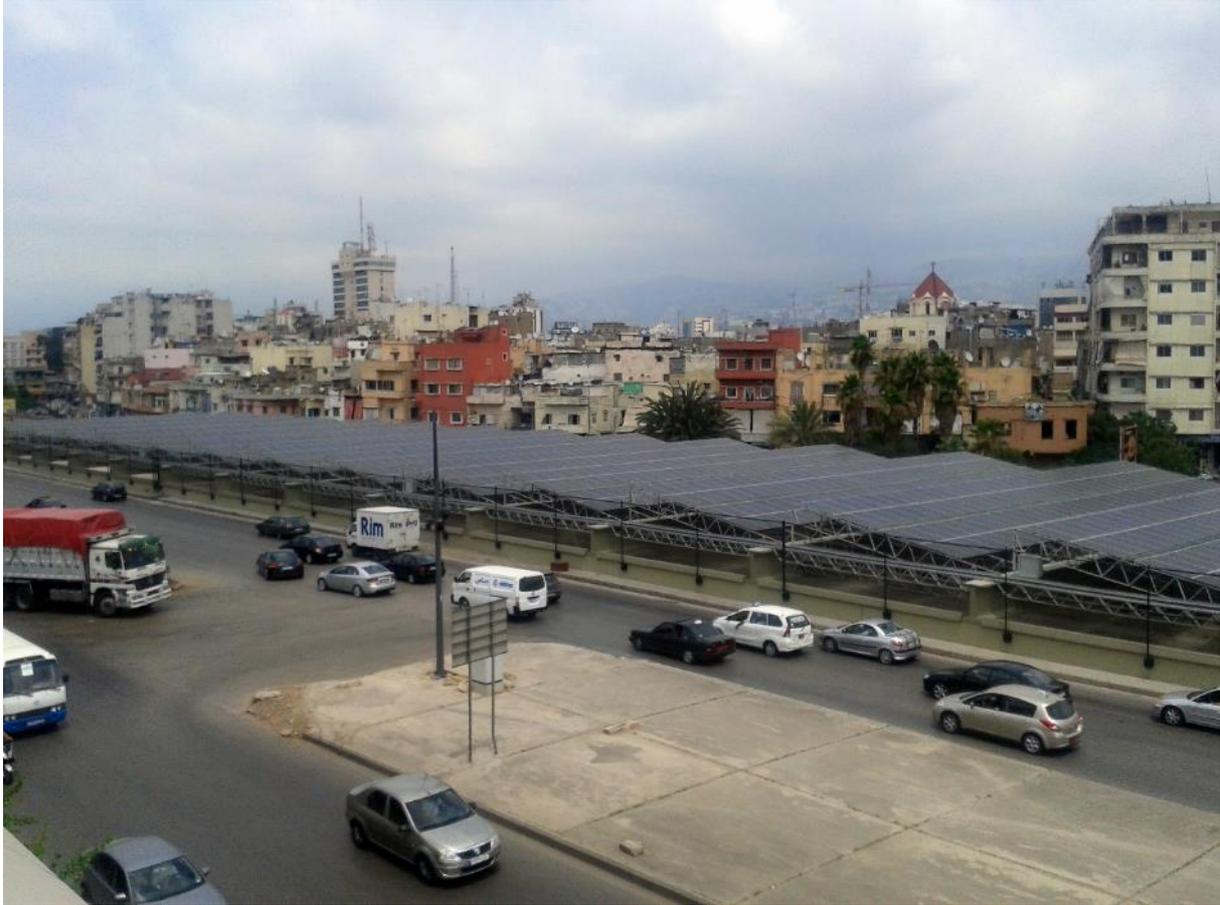
5. Système de production photovoltaïque public installé sur la rivière de Beyrouth et injecté sur le réseau national Électricité du Liban, Beirut River Solar Snake, Liban (Eric Verdeil, 2018)
