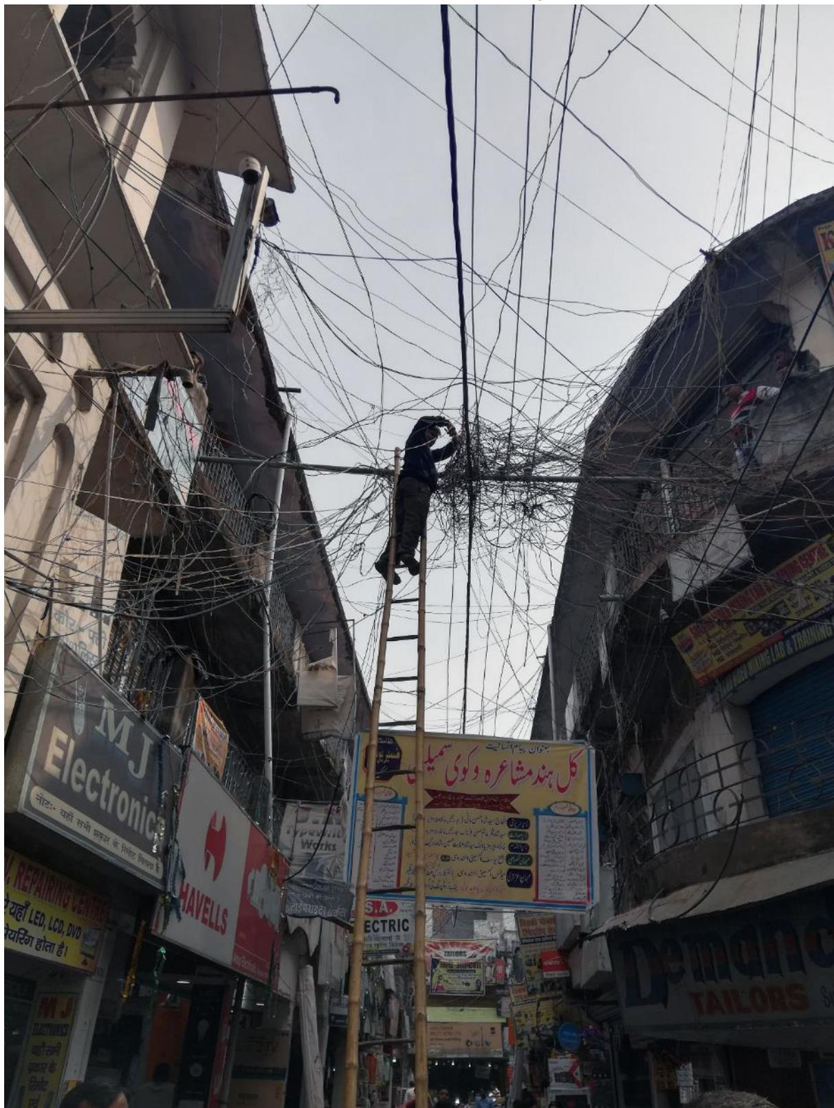
3. Un technicien répare un branchement défaillant. L'entremêlement des fils électriques nécessite des interventions régulières. Shah Market, Bhagalpur, Inde (Bérénice Girard, 2019)
