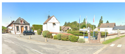
24– Vue de l'église et de la mairie de Saint-Laurent-des-Bois [capture Google-Earth Street View 2024]
