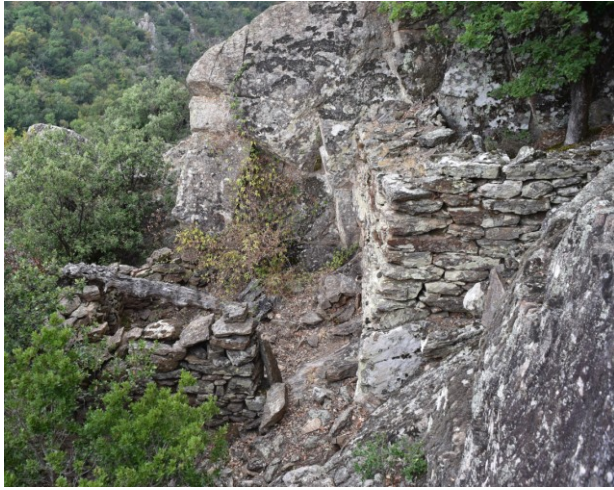
Fig. 40 – Vue depuis le sud des murs méridionaux des structures B4, à gauche, et B5, à droite. Photo André Théron
