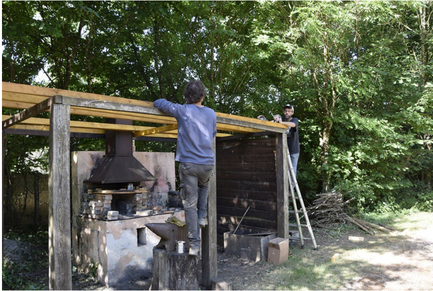
Figure 1, réfection de la toiture de l'espace forge
