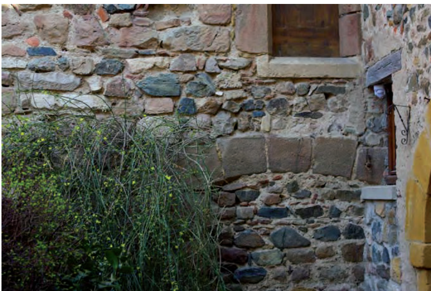
C 2.80 Cuvier, mur sud, parement externe : appareil de la maçonnerie M 17 entre la porte (b 7) et la fenêtre (b 8)
