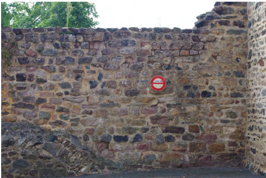
Jardins ouest : vue générale du mur nord, parement externe
