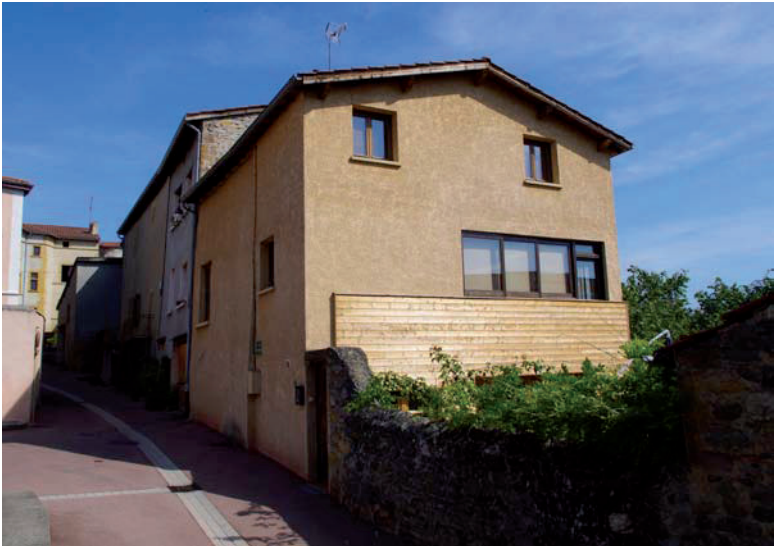
Maison sud-ouest : vue générale depuis le sud-ouest
