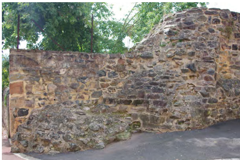
Jardins ouest, mur nord, parement externe : vestiges d'une tourelle d'escalier ?
