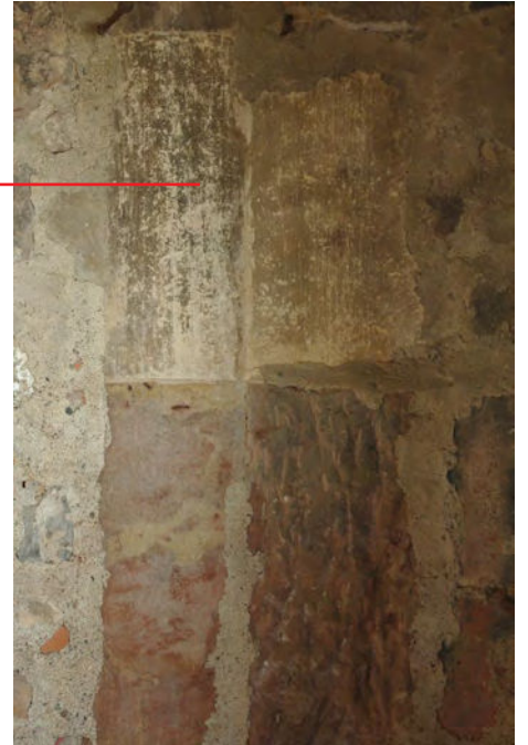
Détail du fût du support n° 3
