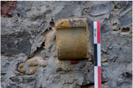
Deuxième maison sud-ouest : détail du corbeau nord
