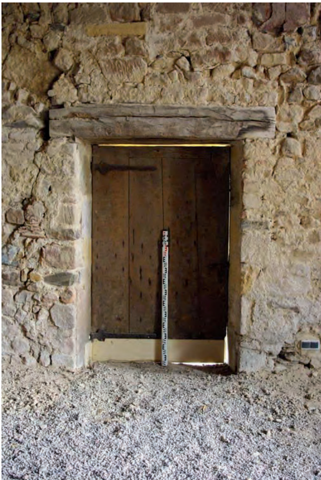
C 2.47 Cuvier, mur ouest, parement interne : porte (b 4)
