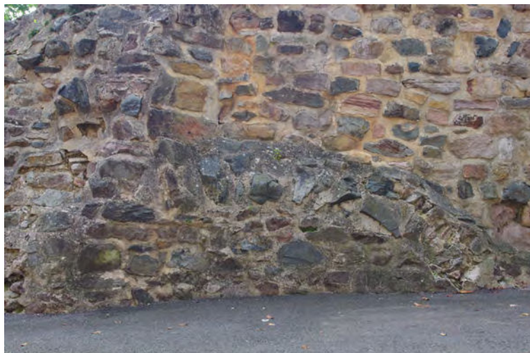
Jardins ouest, mur nord, parement externe : vestiges d'un arc bouché ?
