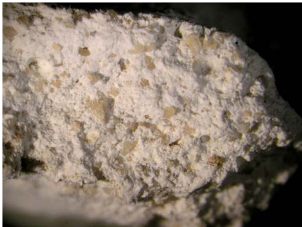
Abb. 1498.Probe 14.1: Leichter, luftiger Kalkmörtel mit geringem Feinkornanteil (Bruchfläche; LM).
