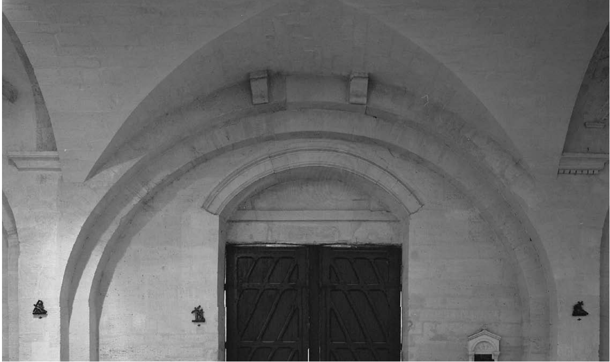
Abb. 98 Innenwand der Westfassade - Mittlere Partie Konsolen im Portalbogen
