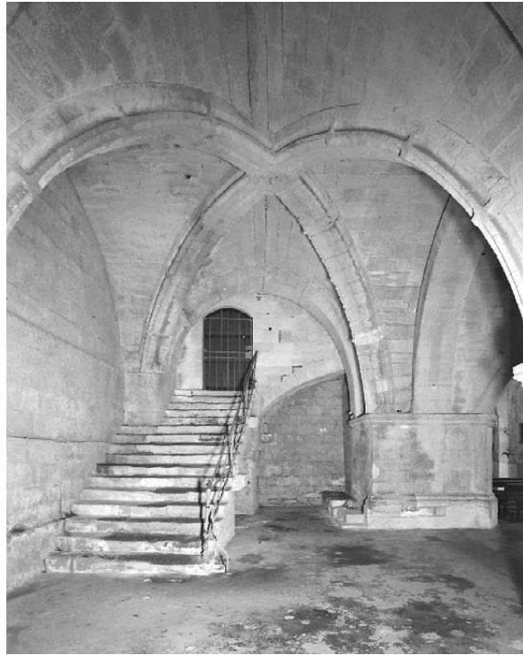
Abb. 96 Nordwestliche Joche der Krypta Blick auf die Treppe in die Oberkirche
