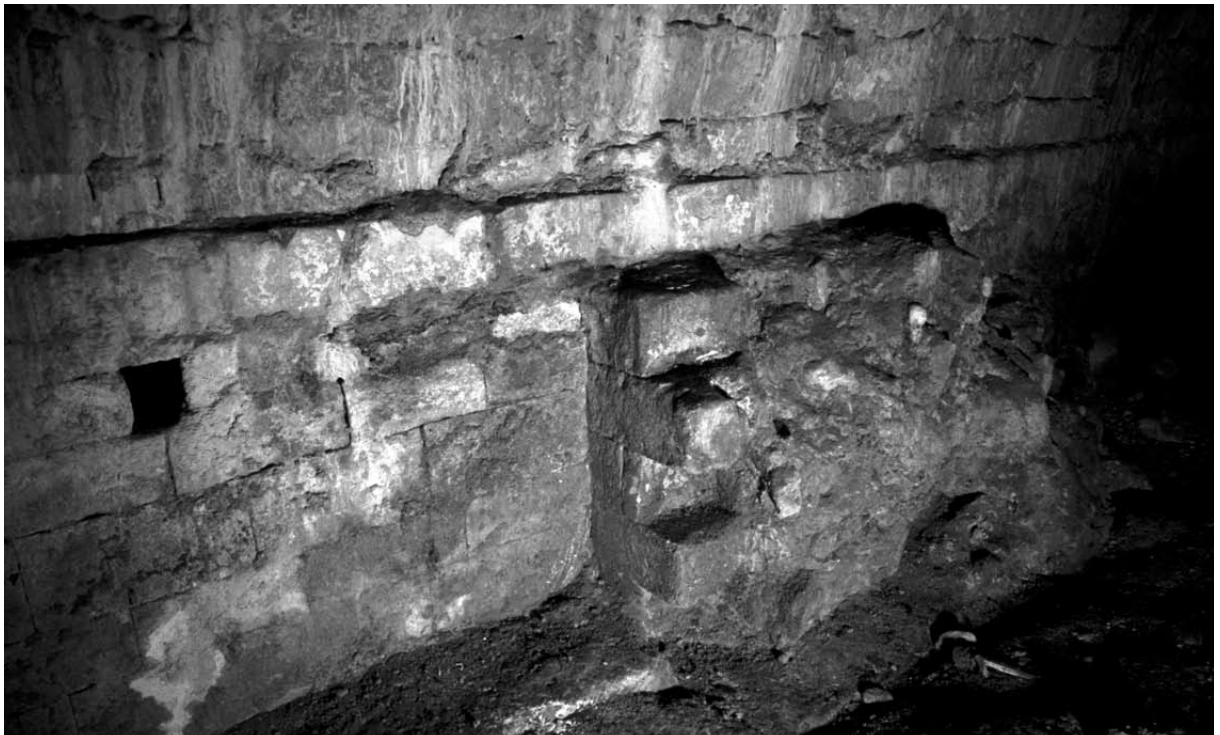
Abb. 83 Raum unter der Treppe Tonnenfundament mit heterogenen Strukturen westlich der Westfassade 251
