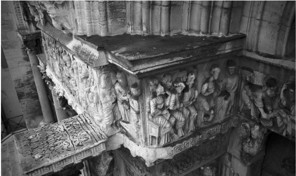
Abb. 110 Auflager der Hauptportalarchivolten
