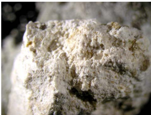
Abb. 1498.Probe 08.1: Sehr luftiger, weicher Kalkmörtel mit geringem Feinkornanteil.
