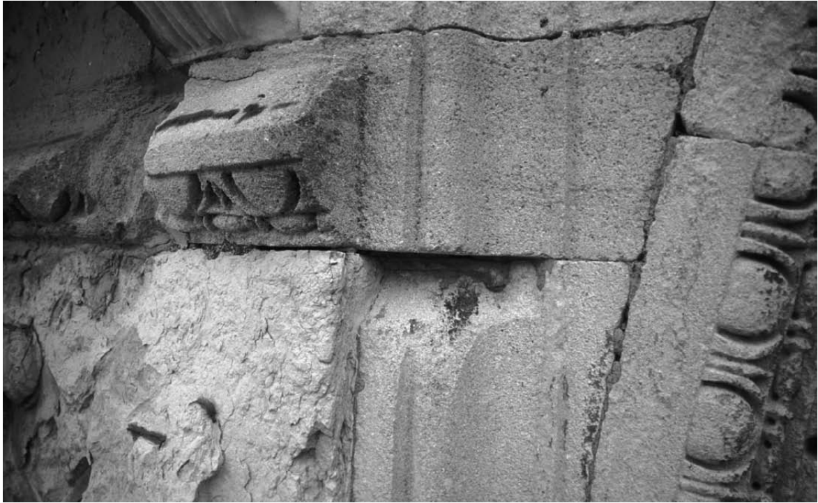
Abb. 132 Südlicher Passionsfries Eisenverklammerung einer Platte in Bleibett
