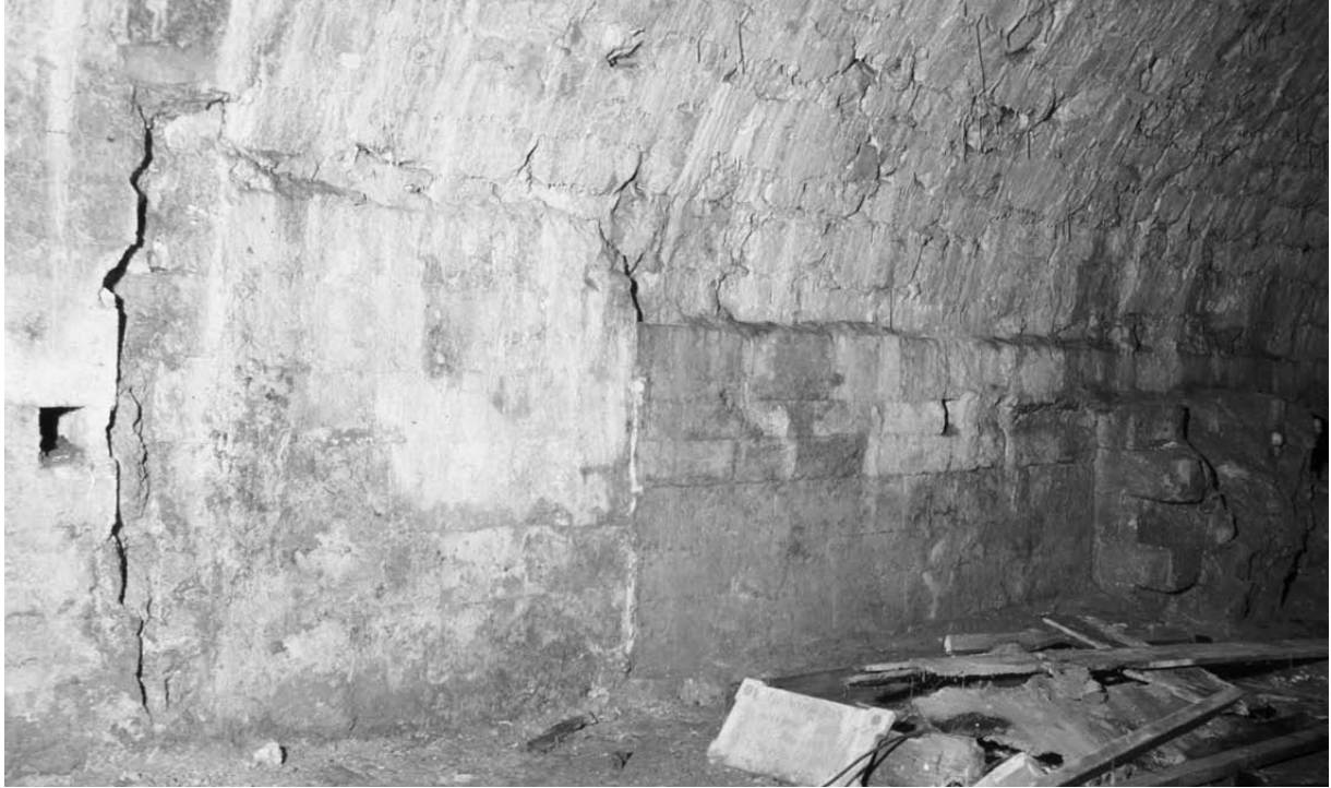
Abb. 82 Raum unter der Treppe Tonnenfundament mit heterogenen Strukturen westlich der Westfassade
