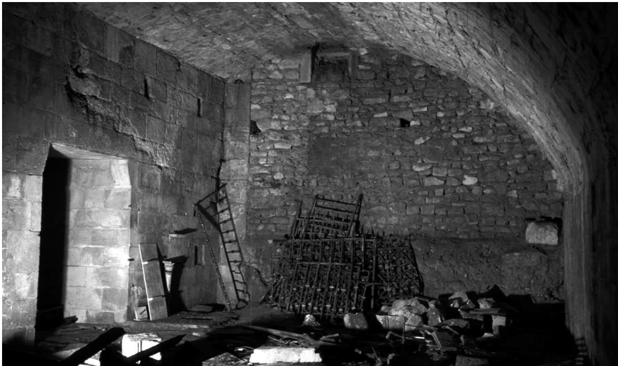
Abb. 90 Raum unter der Treppe Südliche Stirnwand
