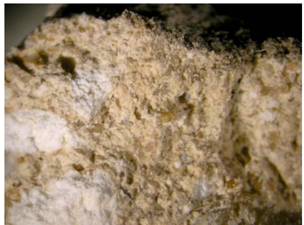
Abb. 1498.Probe 17.1: Mürber, braungelber Kalkmörtel mit großen Kalkspatzen (Bruchfläche; LM).
