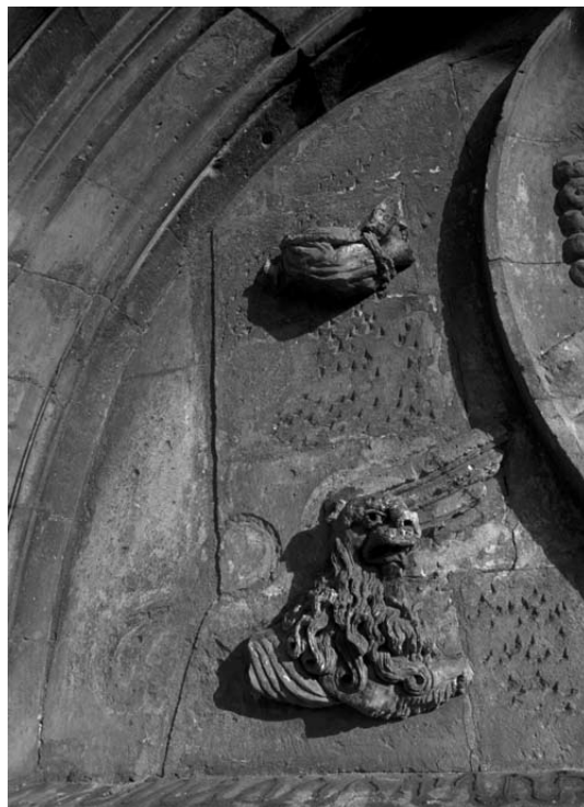
Abb. 79 Tympanon des Hauptportals mit Reparaturen des 17.Jh. Reste der figürlichen Darstellungen aus Gips (Engel und Löwe)
