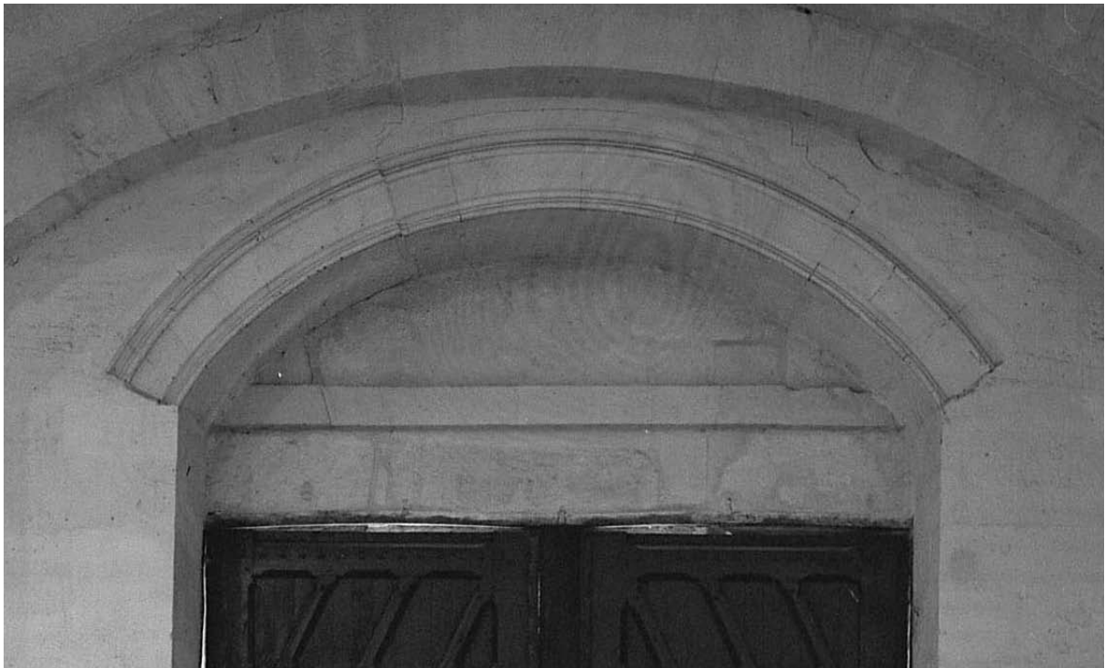
Abb. 111 Entlastungsbogen für den Sturz im Hauptportal
