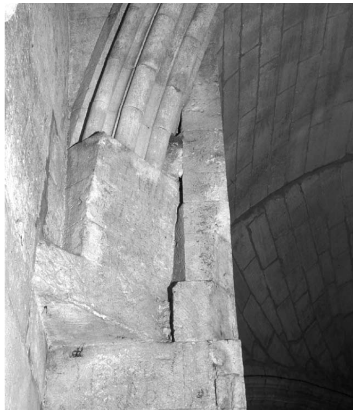
Abb. 93 Nachträglicher Einbau der Rippenwölbung in die südliche Vorlage der Westwand
