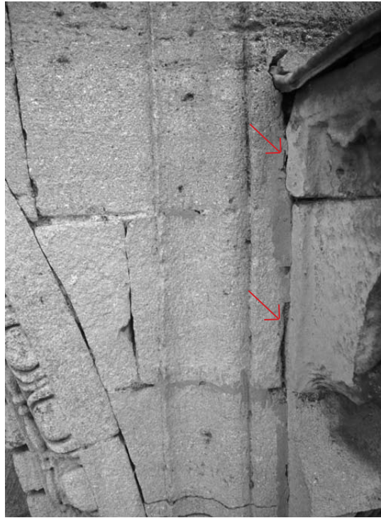
Abb. 114 Nördliches Konsolengesims Nachträglicher Anschluss von Konsole und Gesims in die Wand
