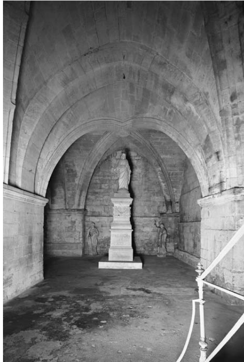
Abb. 66 Nördliches Joch der Kryptawestwand (A. Schlamann)
