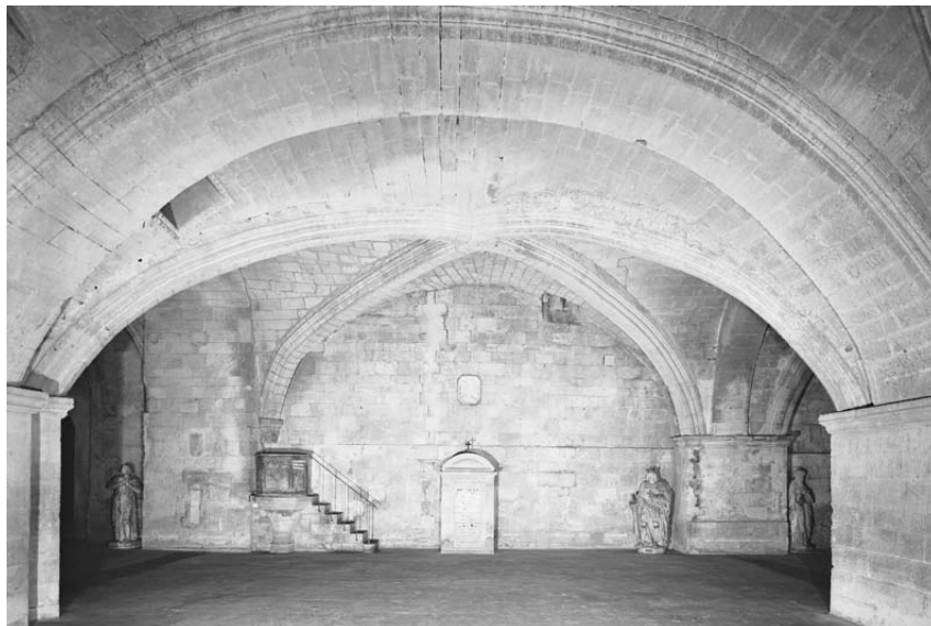
Abb. 63 Mittleres Joch der Kryptawestwand - Ausbildung unterschiedlicher Wandvorlagen (A. Schlamann)
