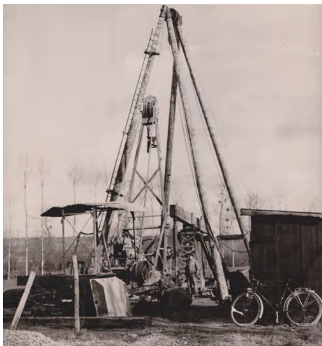
Figure 16 . Essai de forage profond sans les prés des marais à Saint maixent. Vers 1950. AD79 135 J 16
