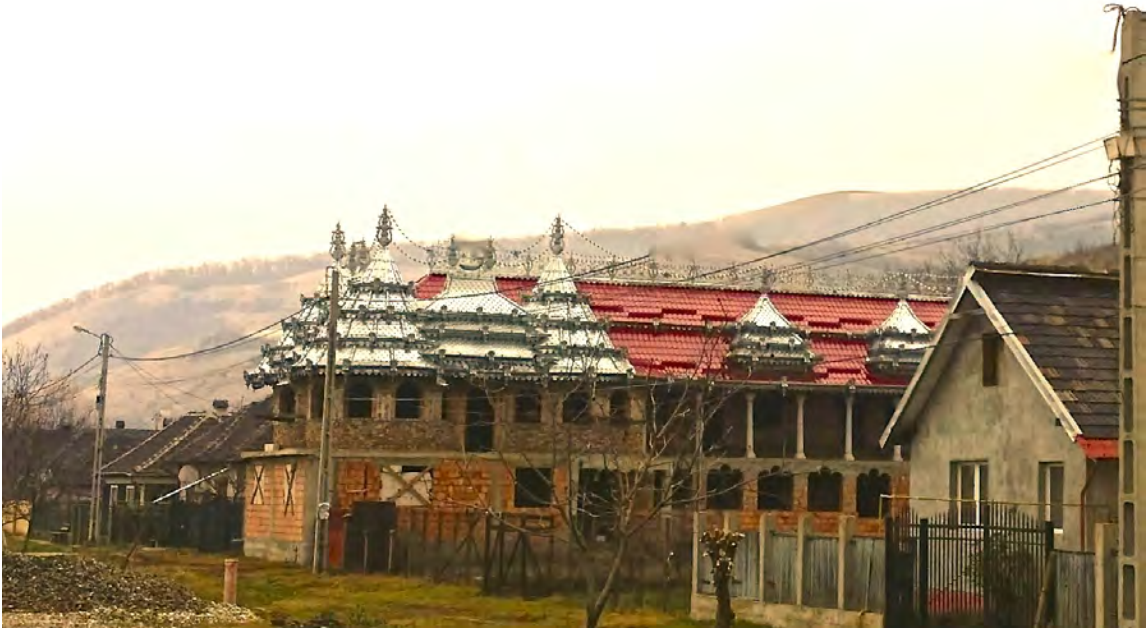
Illustration 1 : Architecture typique d'une villa tsigane roumaine (dont souvent la construction n'est pas terminée)
