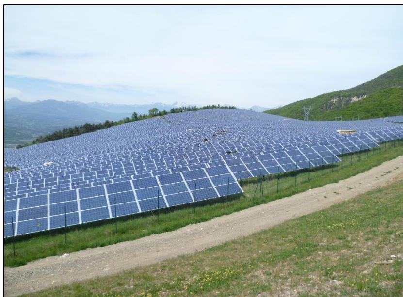
Photo 20 – Le PPVS de Curbans (Alpes-de-Haute-Provence), exploité par ENGIE, est implanté sur des parcelles naturelles du Col des Blaux
