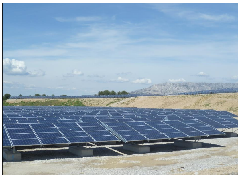
Photo 32 – La CPVS de Gardanne (Bouches-du-Rhône), exploitée par URBASOLAR, avec ses modules PV silicium posés sur des plots de béton (en arrière-plan la montagne de la Sainte-Victoire)
