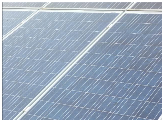
Photos 2 & 3 – La CPVS de Saint-Jean-du-Pin (Gard), exploitée par LA COMPAGNIE DU VENT, utilise des modules PV basés sur la technologie silicium monocristallin
