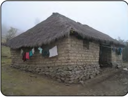
a Site : Village de Kewiña dans la vallée d'Arma (zone 4) Obs: Maison actuelle typique, avec les assises du mur en pierre
