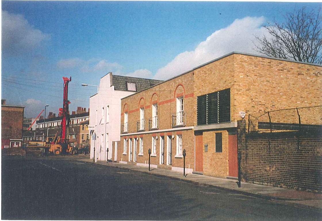
Photographie 10 - Un exemple de gentrification diffuse à l'extrémité est de Lindley Street. Quatre logements gentrifiés et isolés dans un quartier de logement social (arrière plan). A noter le style "post-avant-gardiste" donné à la rénovation du premier logement
