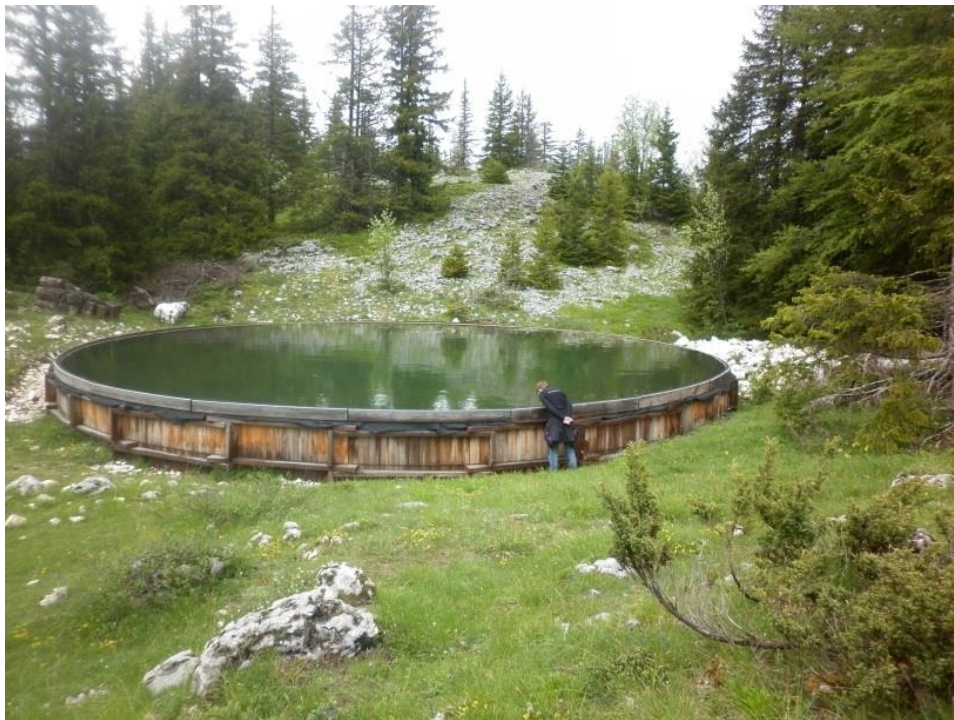
Photo 13 : Impluvium de l'alpage de Darbounouse, juin 2016
