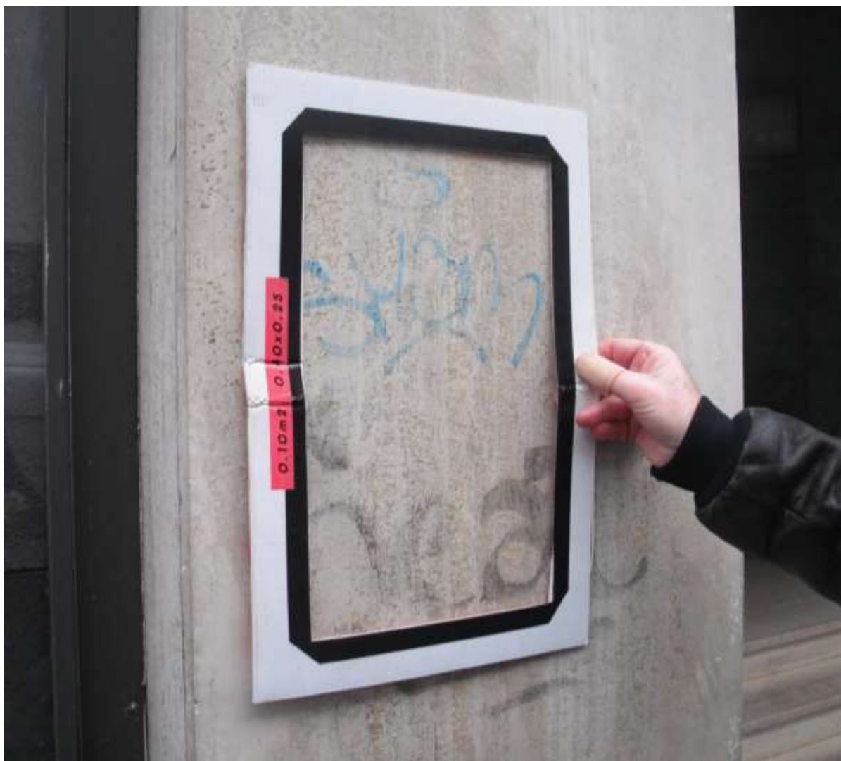
Figure 16 - Gabarit de 0,10m 2 utilisé pour mesurer la surface des graffitis non effacés. Photographie de l'auteur, 21 novembre 2012.
