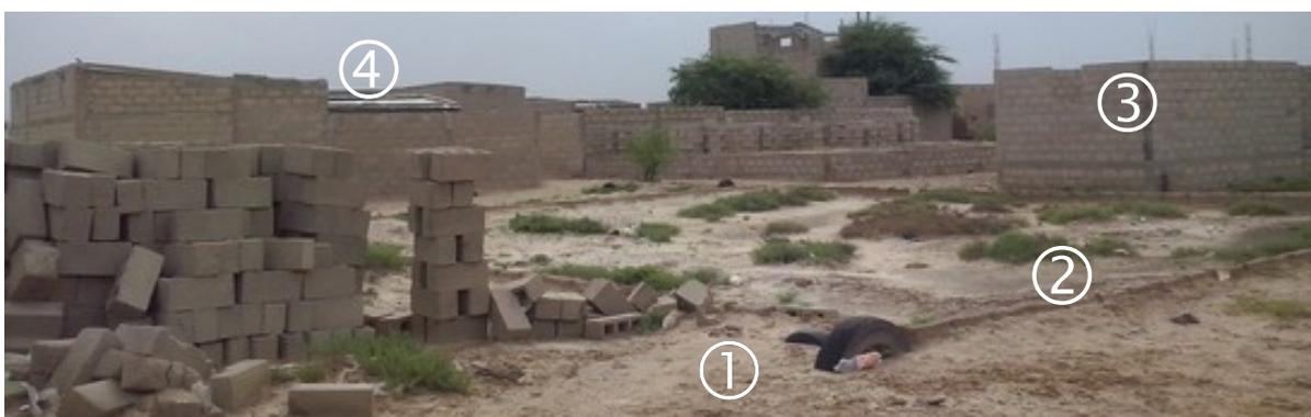
B. Étapes successives de chantier sur un même îlot : (1) bornage de pneus et empilement de parpaings, (2) fondation du mur d'enceinte, (3) mur d'enceinte en construction, (4) gros œuvre terminé.
