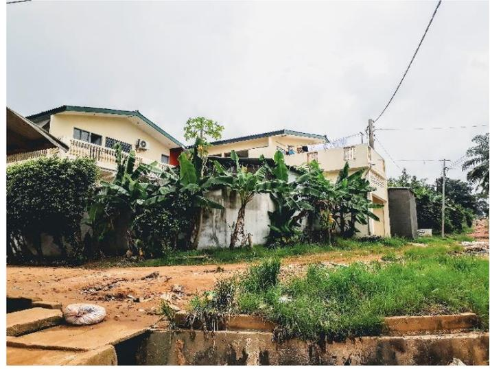
**Photo 33 : Absence totale de caniveaux aux abords de la chaussée à Bingerville** (Source : Notre enquête, 2018)
