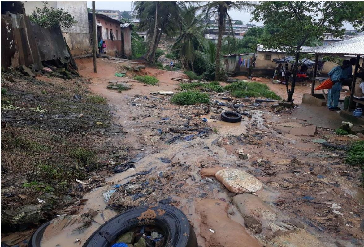
**Photo 46 : Absence d'ouvrage d'assainissement, provoquant des érosions en saison pluvieuse à Anyama**
