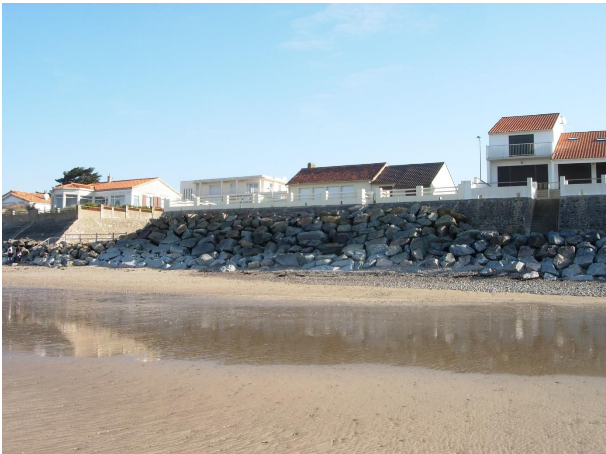
Figure 1.8 : Démaigrissement de plage à Angoulins (Charente-Maritime, février 2009). La première génération d'ouvrages (murs et perrés), en voie de déchaussement, a été renforcée par un enrochement. Les différences de teintes témoignent des variations saisonnières du niveau de la plage ; la nappe phréatique affleure au premier plan
