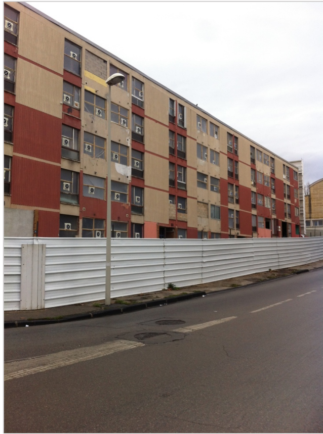
Photographie 7 : Bâtiments des Cèdres nord murés en vue de leur démolition (2016)
