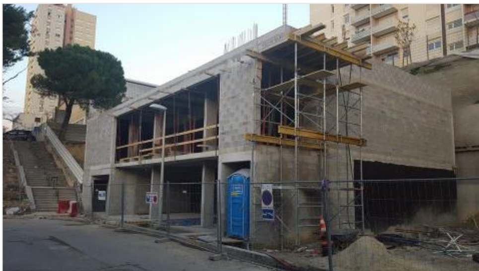
Photographie 16 : Chantier de la mosquée (2016)
