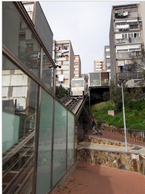
Photographie 12 : L'ascenseur permettant de relier le bas et le haut du quartier (2017)
