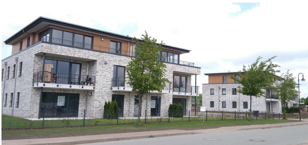
Figure 6.7 - Lotissements en construction à Zarrentin
