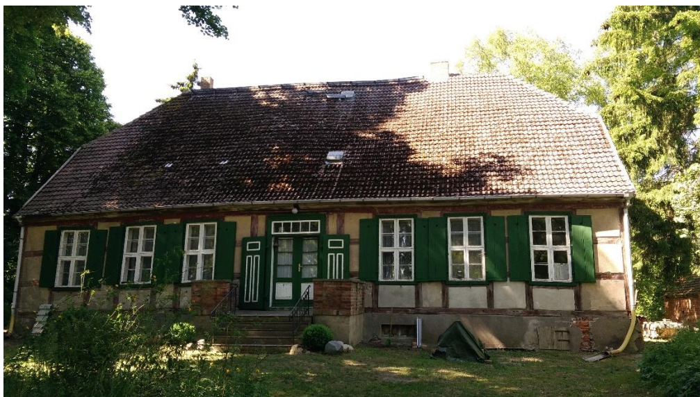
Figure 5.11 - Assainissement d'un ancien presbytère dans la région LEADER de Demmin
