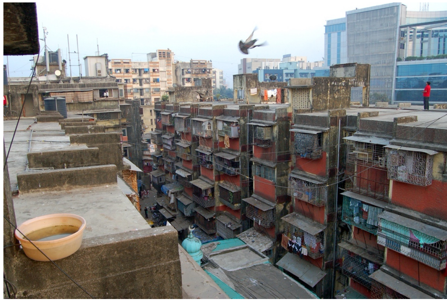
Figure 18 : Bismillah Building, immeuble de relogement construit par la société Solanki & Ass., Ahmed Zakaria Nagar (Behrampada, Mumbai).
