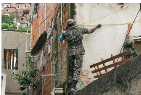
Figure 14 : Employés de l'armée (Força Nacional de Segurança) travaillant sur le chantier du dispositif Cimento Social (Photo : N. Bautès, 2006)
